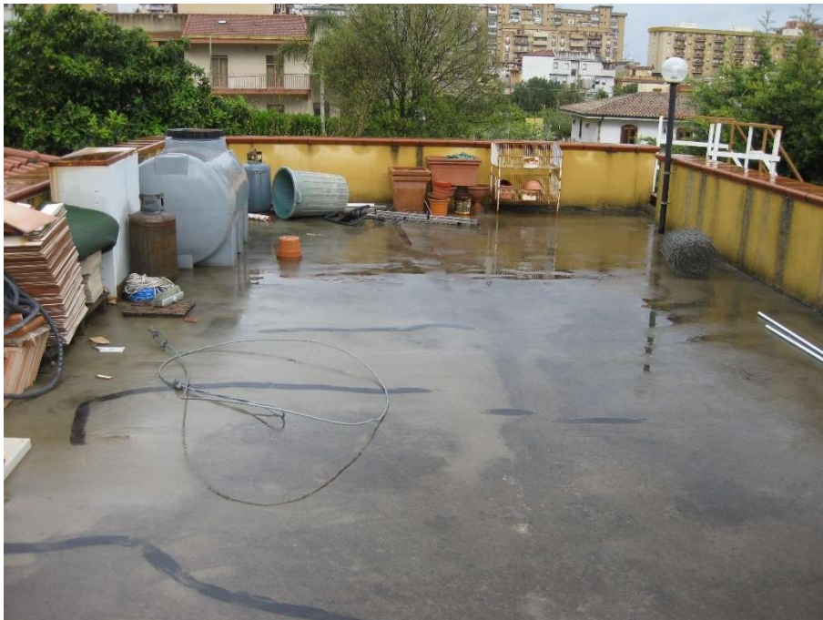
Foto 8: il lastrico solare a copertura del portico
