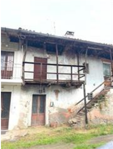
Vista fronte Sud
