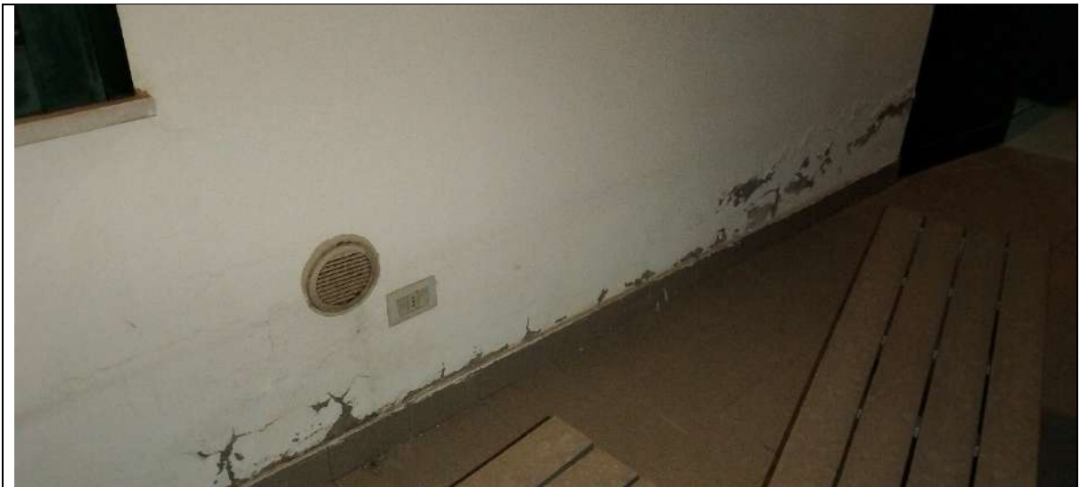
fig. 23. Piano rialzato, balcone annesso a cucina/pranzo: dettaglio dello stato dei luoghi
