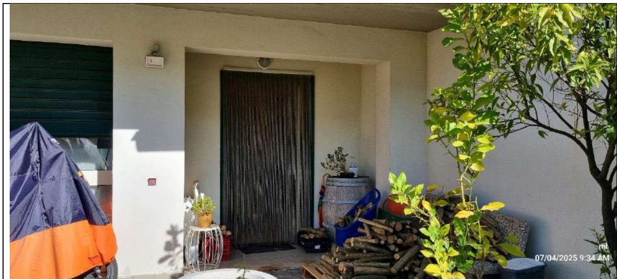
fig. 11. Accesso all'interno della casa dal piano seminterrato
