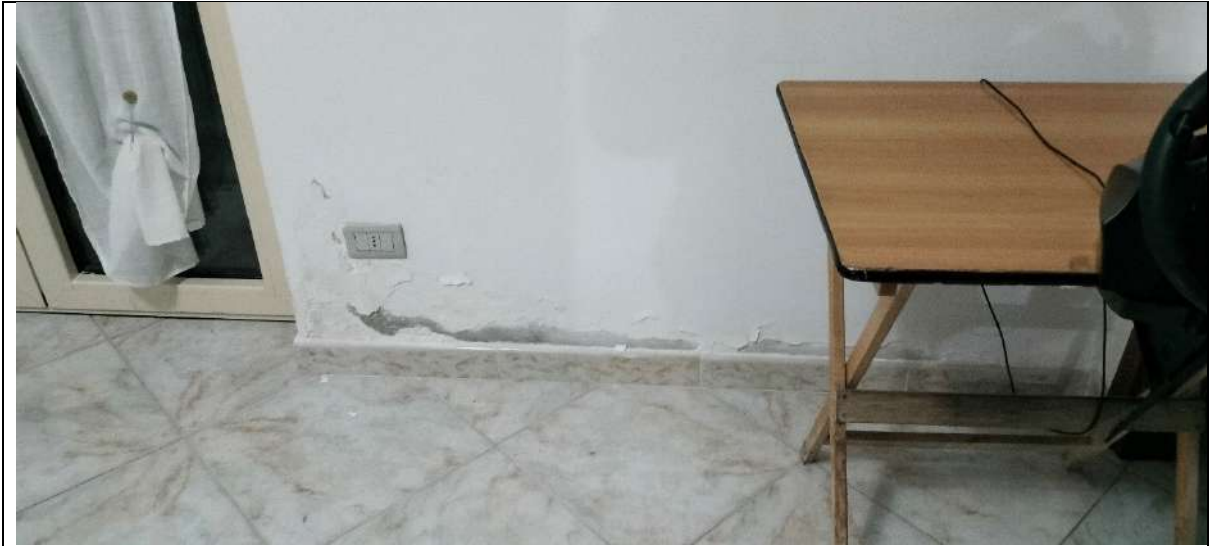
fig. 22. Piano rialzato, cucina/pranzo: dettaglio dello stato dei luoghi
