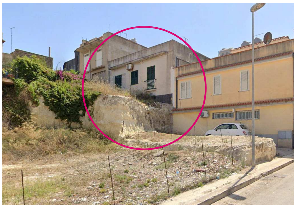
Prospetto nord su cortile via Mantova.
