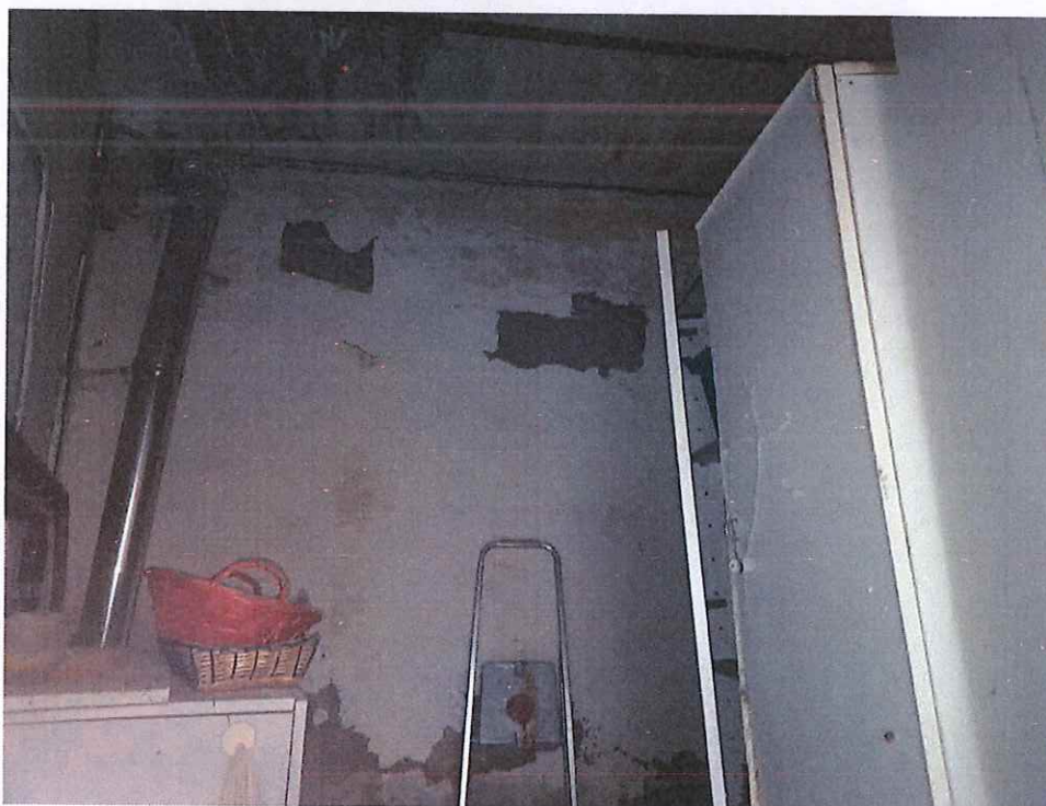
Interni locale lavanderia p.T.
