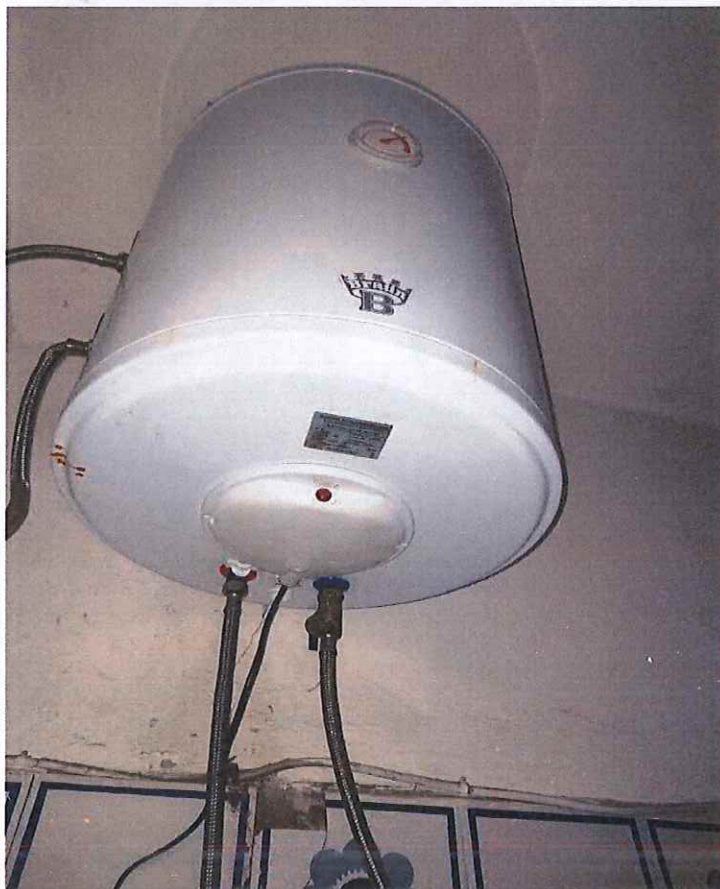
Boiler elettrico
