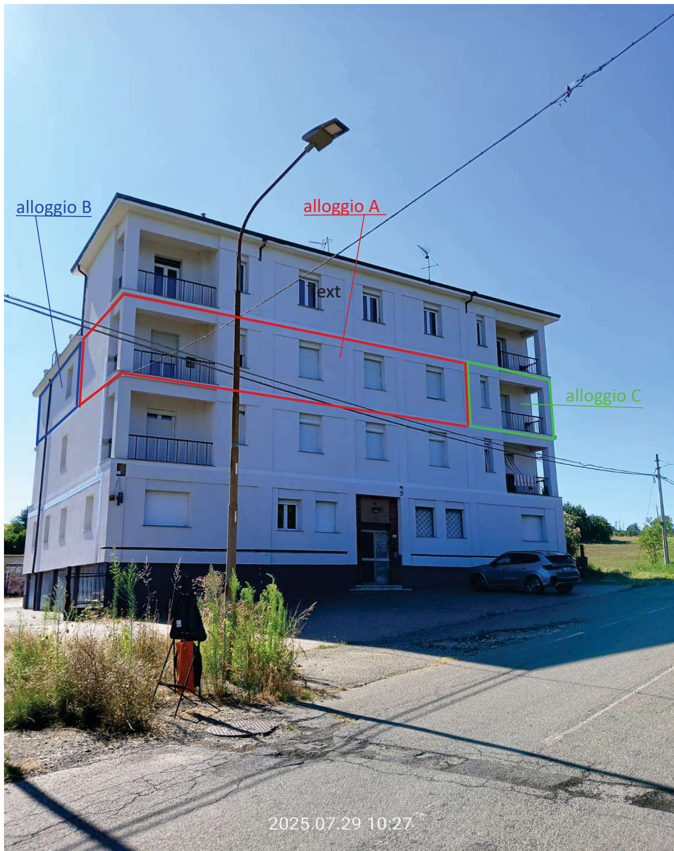
Foto n. 1 – facciata principale fabbricato condominiale.
