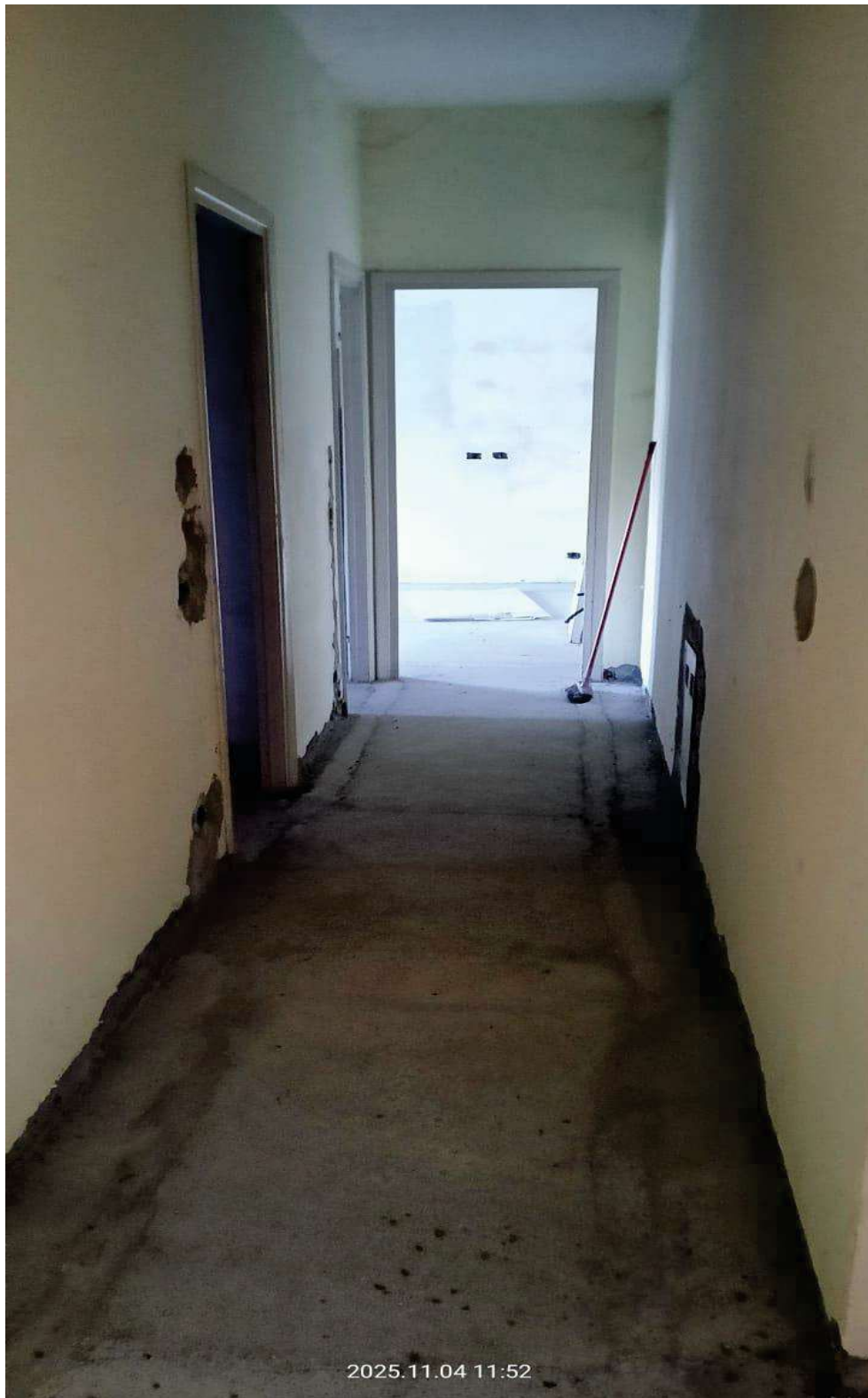
Foto n. 4 – corridoio alloggio Lotto A
