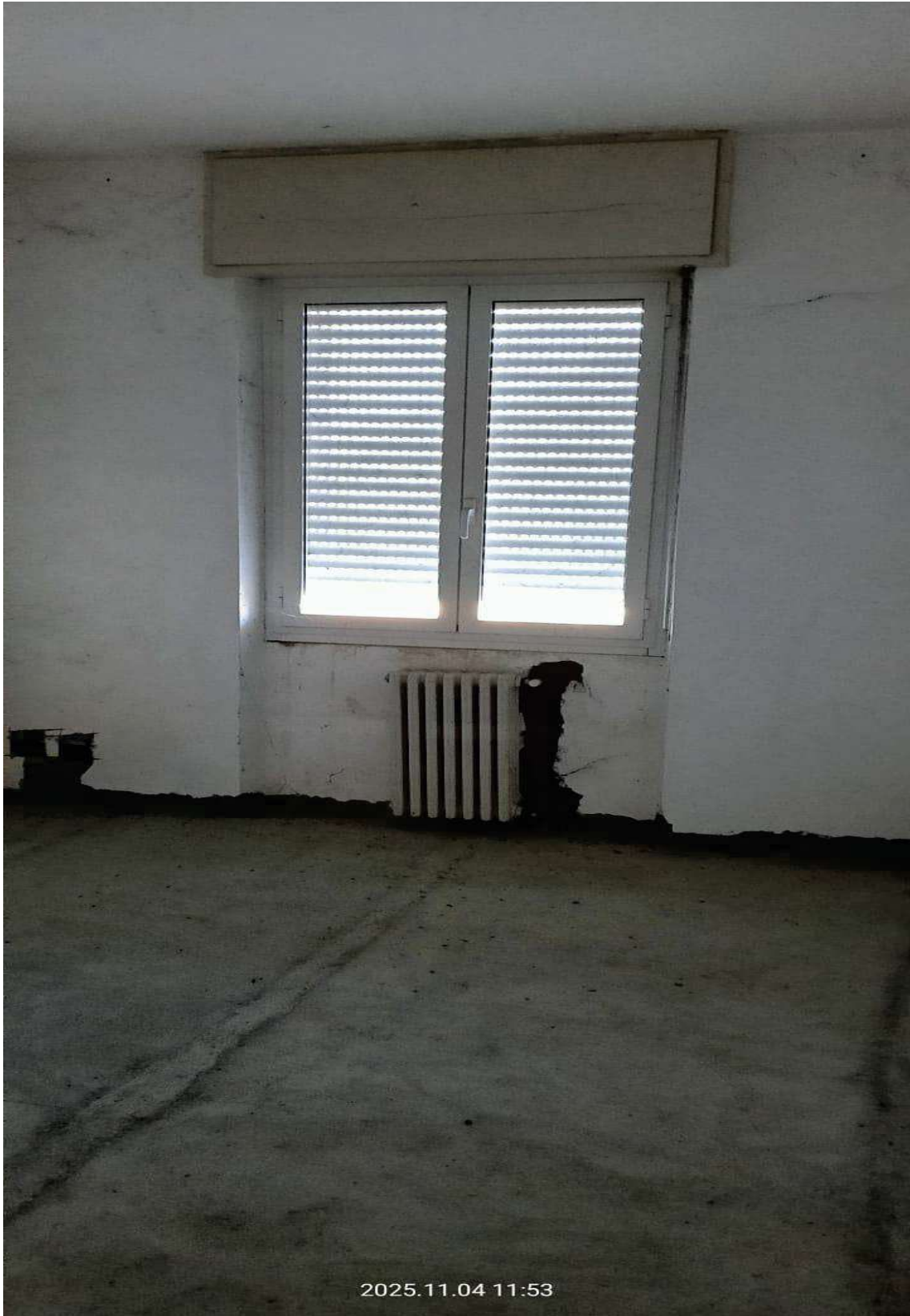
Foto n. 5 – Camera alloggio lotto A
