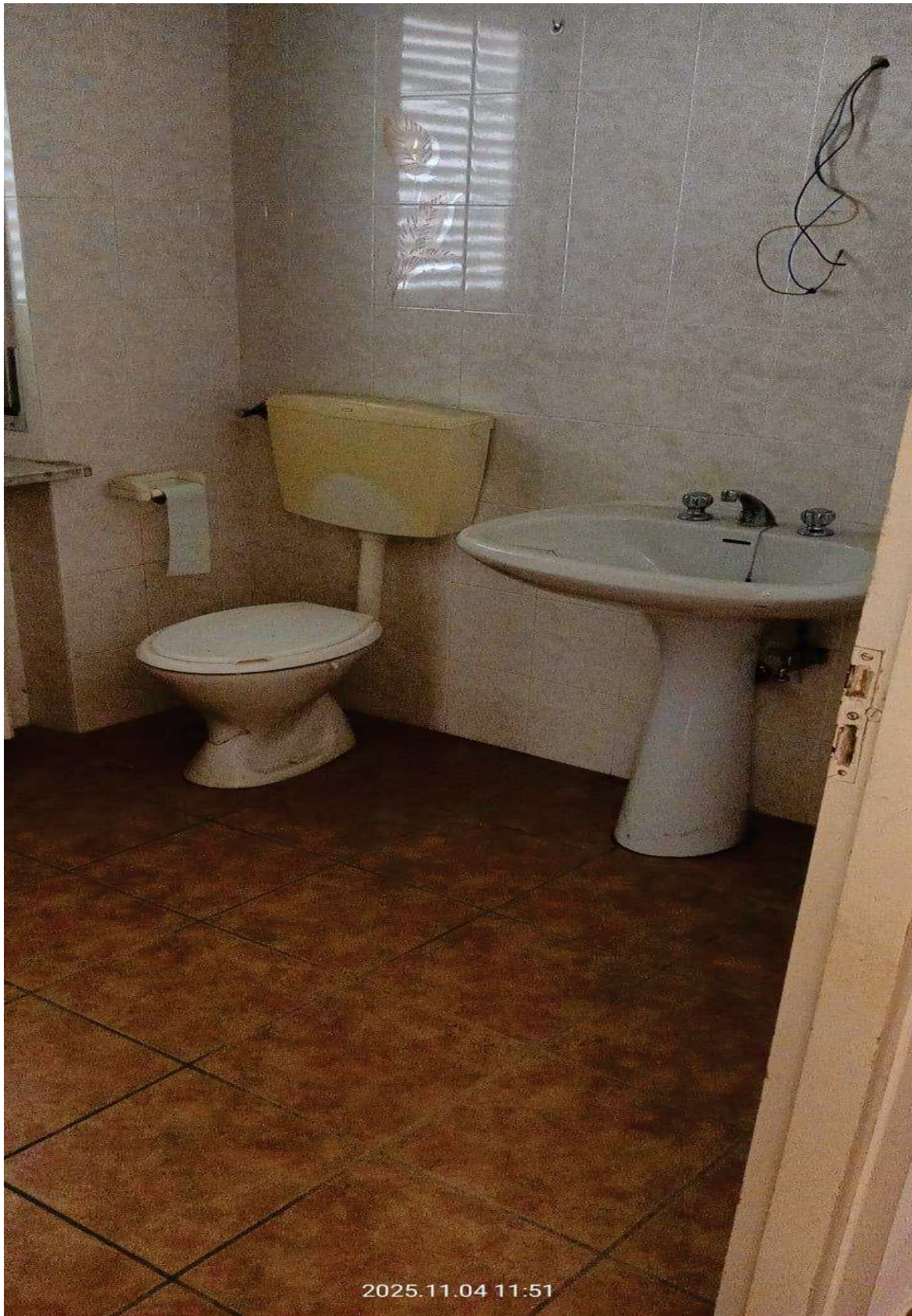
Foto 16 – bagno alloggio lotto C
