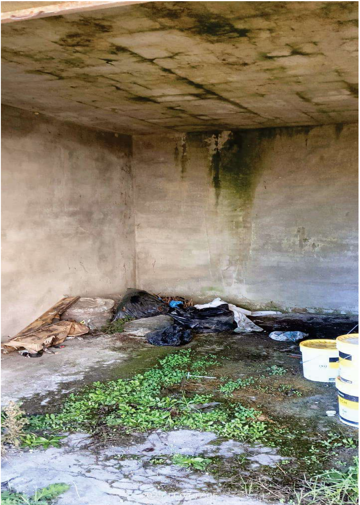
Foto 18 – interno box auto lotto D.
