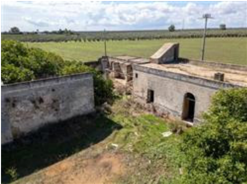
interno dx e piazzale della Masseria
