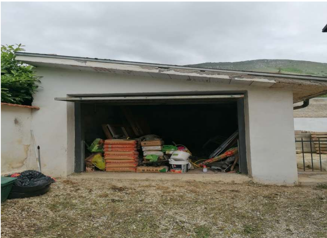
foto n° 12 “garage sub2, con accesso indipendente dalla corte esterna ”
