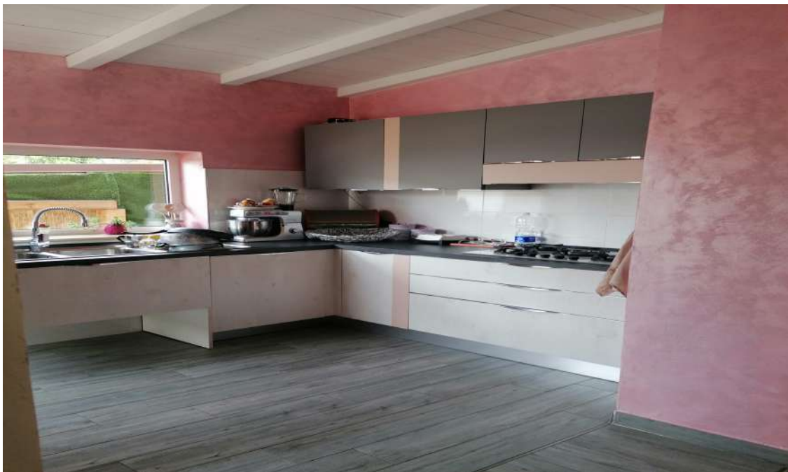
foto n° 6 “particolare cucina sub3, realizzata in ampliamento difforme”
