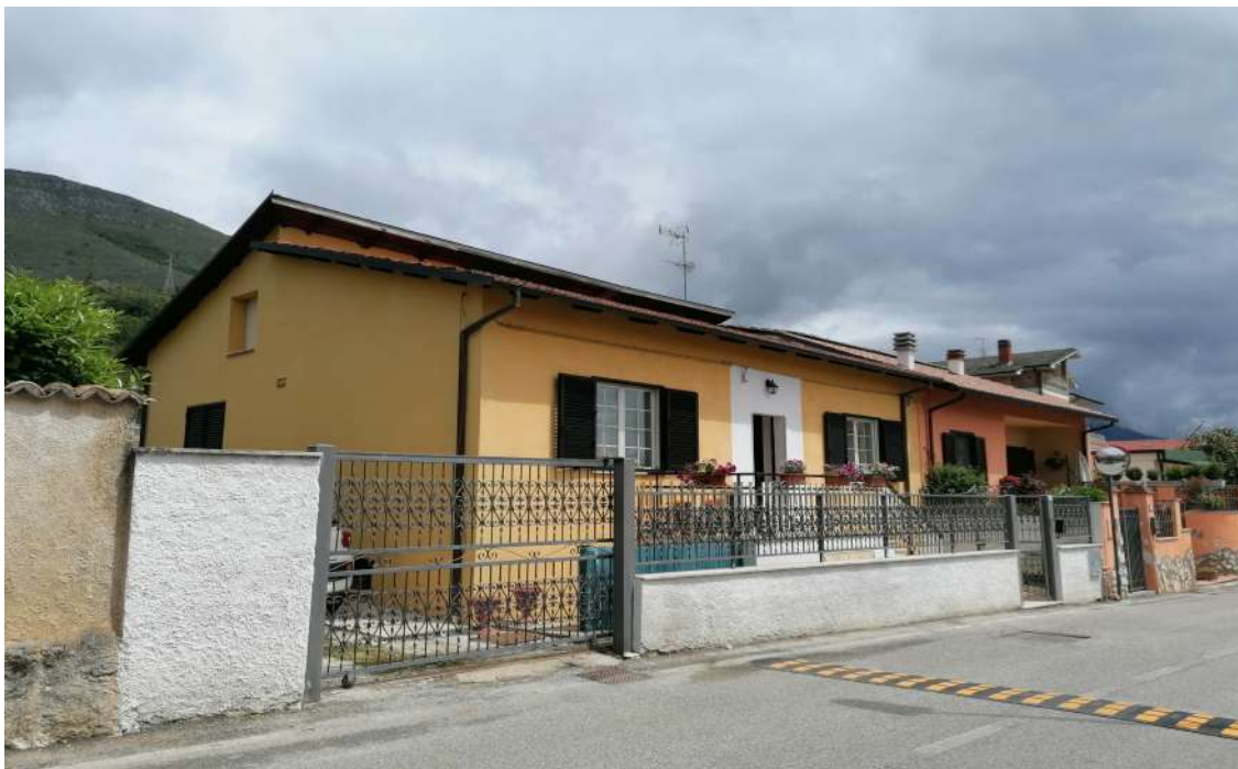
foto n° 2 “Vista esterna immobile (sub3) da Via Monte Cervaro ”
