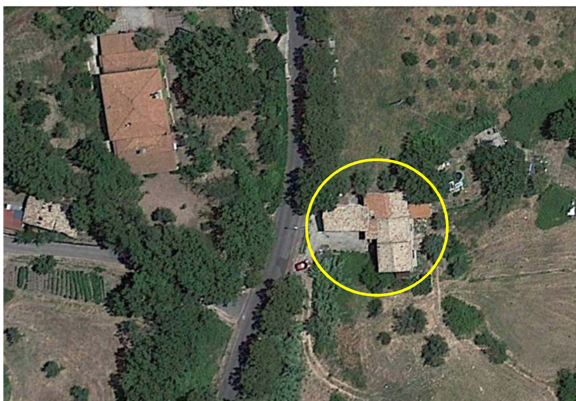
VISTA AEREA CON UBICAZIONE DELL'IMMOBILE VIA ACHERUNTIA N. 16 – MENDICINO (CS)
