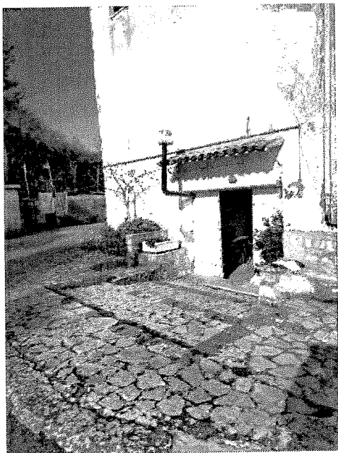
Ingresso Deposito al piano SS1
