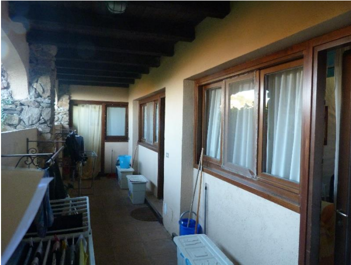
CESPITE N. 3 Accesso dal porticato
