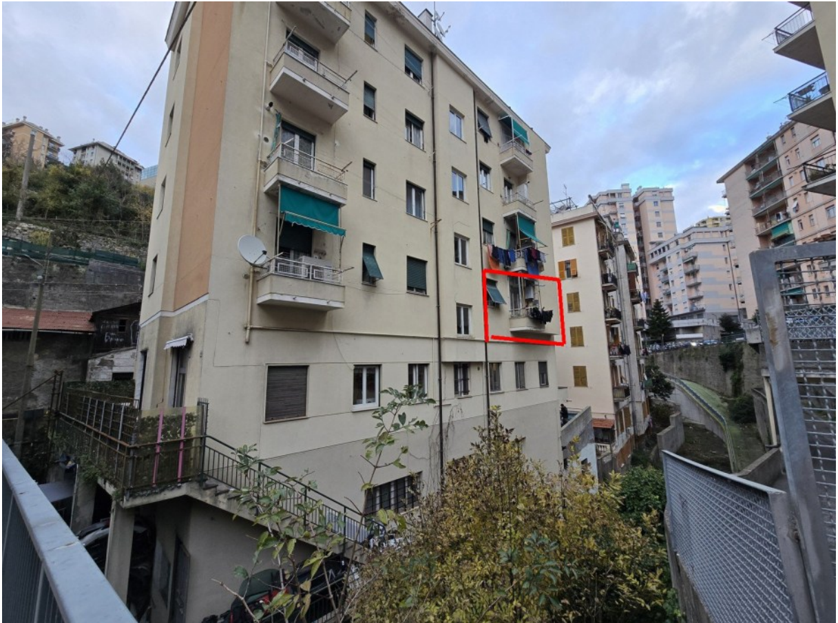
Fabbricato con appartamento evidenziato su Rio Fereggiano
