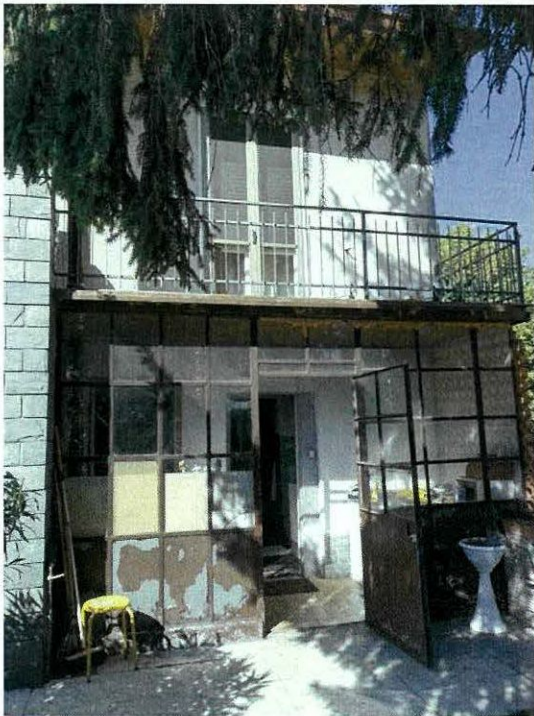
foto 3 – vista esterna dell’immobile.
