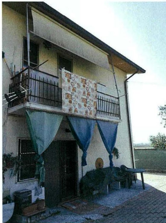
foto 4 – vista esterna dell’immobile.
