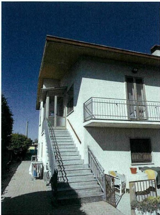
foto 1 – vista esterna dell’immobile.
