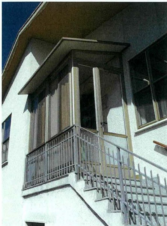
foto 21 – vista esterna disimp. ingresso P.1.
