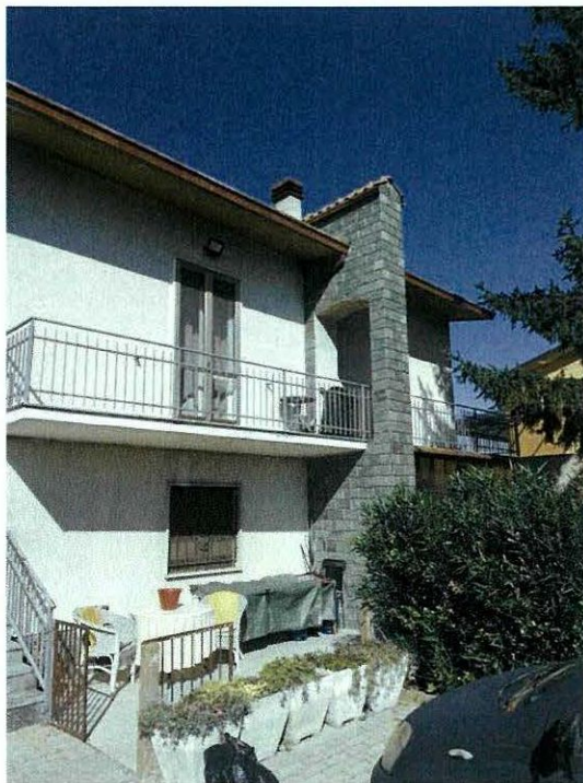
foto 2 – vista esterna dell’immobile.
