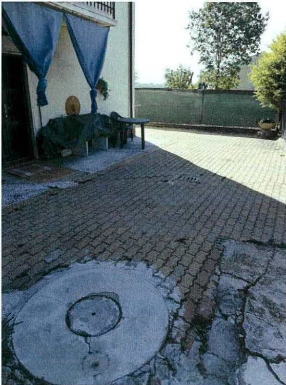
foto 34 – vista area esterna pertinenziale.
