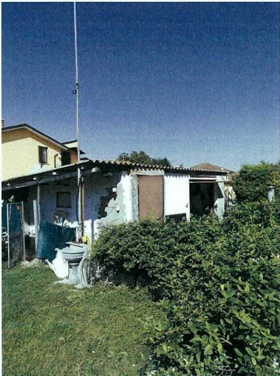
foto 30 – vista esterna autorimessa.
