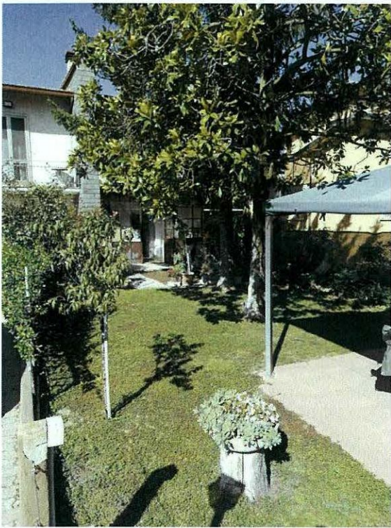
foto 5 – vista esterna dell'immobile.
