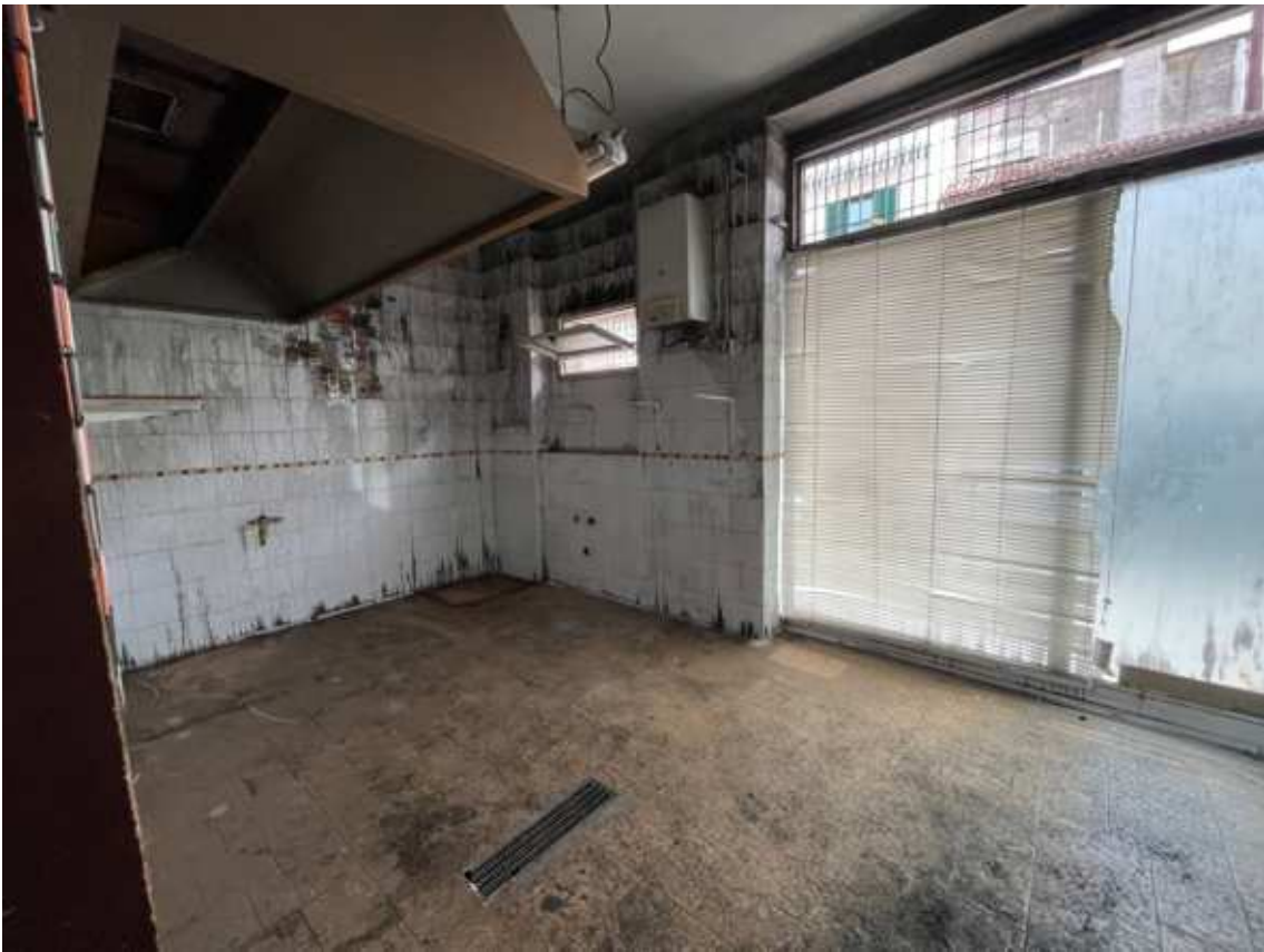
Fig.12 – Vista su vano adibito a cucina
