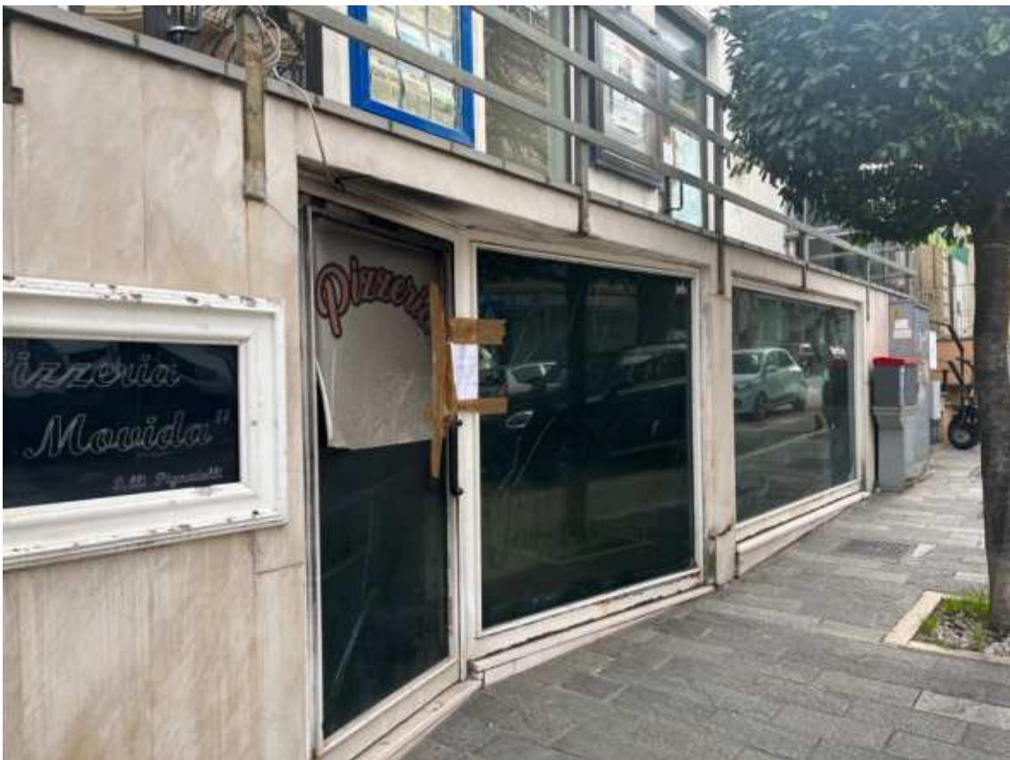
Fig.2 – Vista dell'ingresso del locale commerciale posto su Corso Garibaldi al civico n.80
