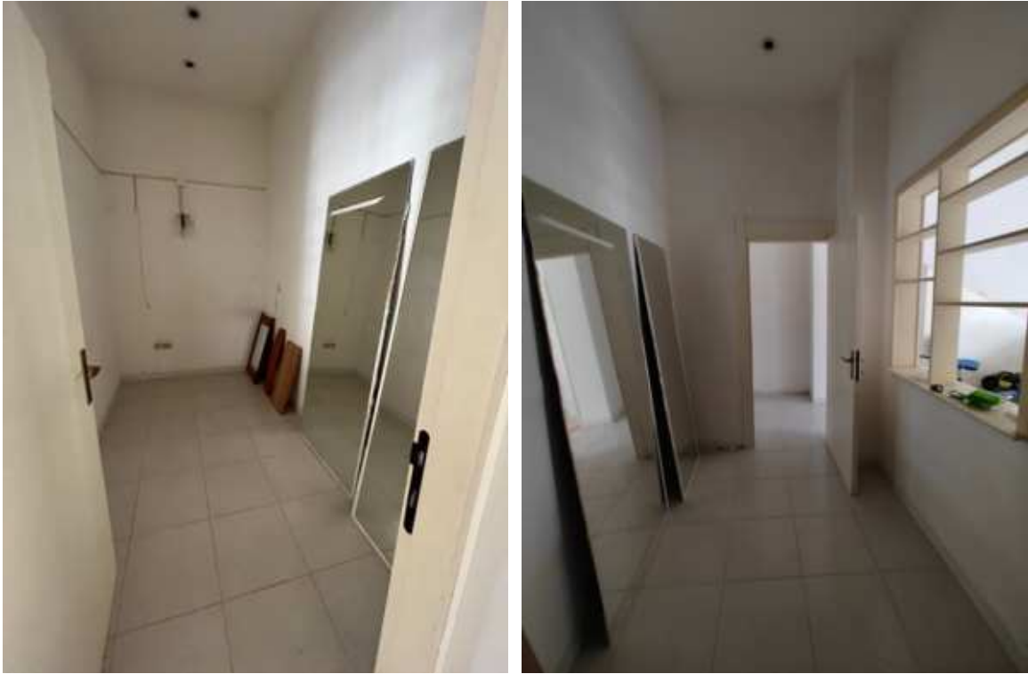
Figg.6-7 – Vista su Vano adibito a deposito attiguo al vano d'ingresso
