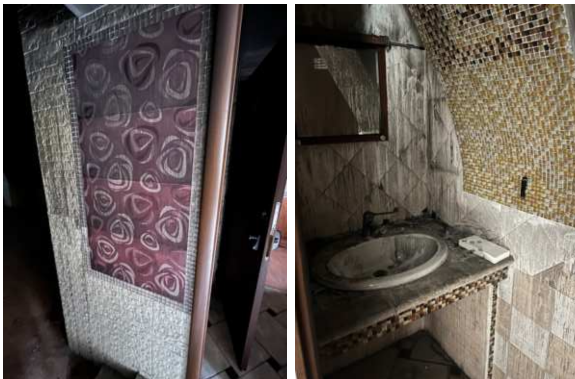
Figg.6-7 – Vista su Zona Antibagno per gli utenti
