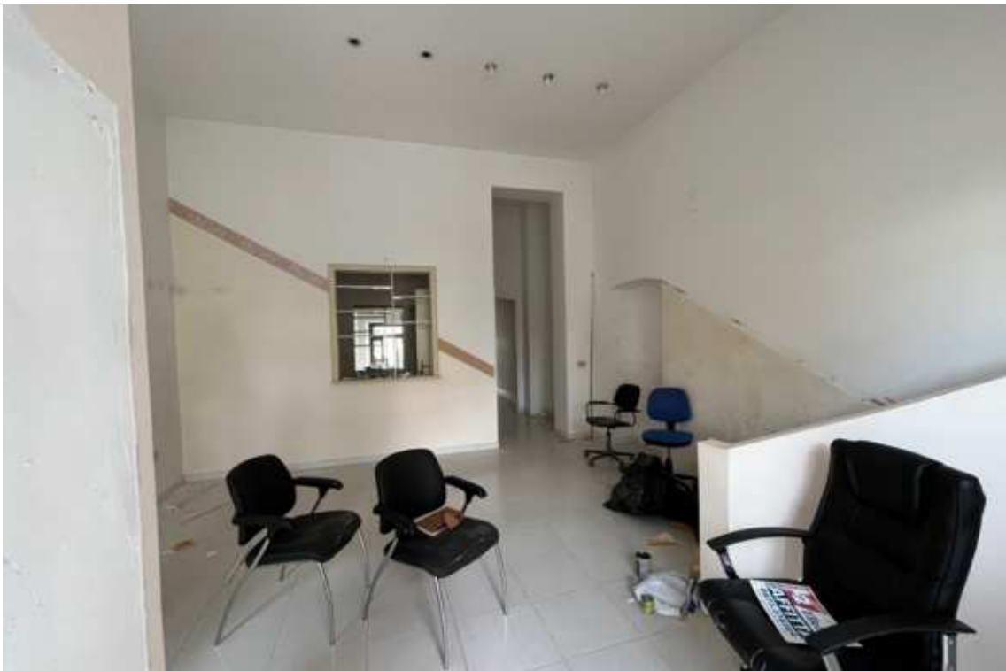
Fig.5 – Vista su vano d’Ingresso da ovest verso est
