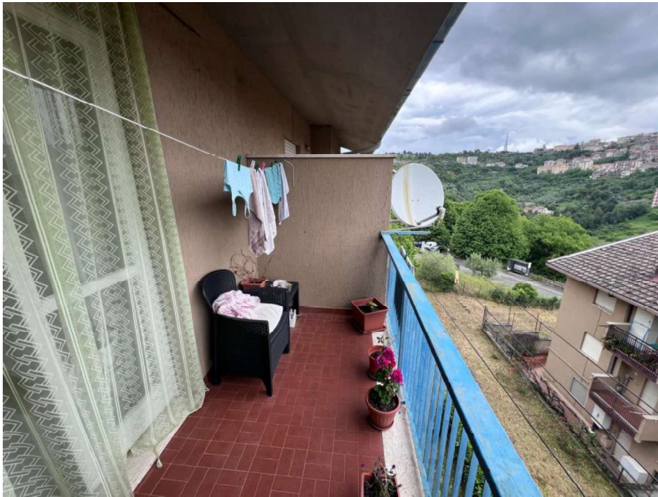
Foto 9. Vista esterna. Balcone adiacente al soggiorno
