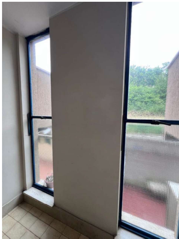
Foto 5-6 Vista interna. Vano scale condominiale
