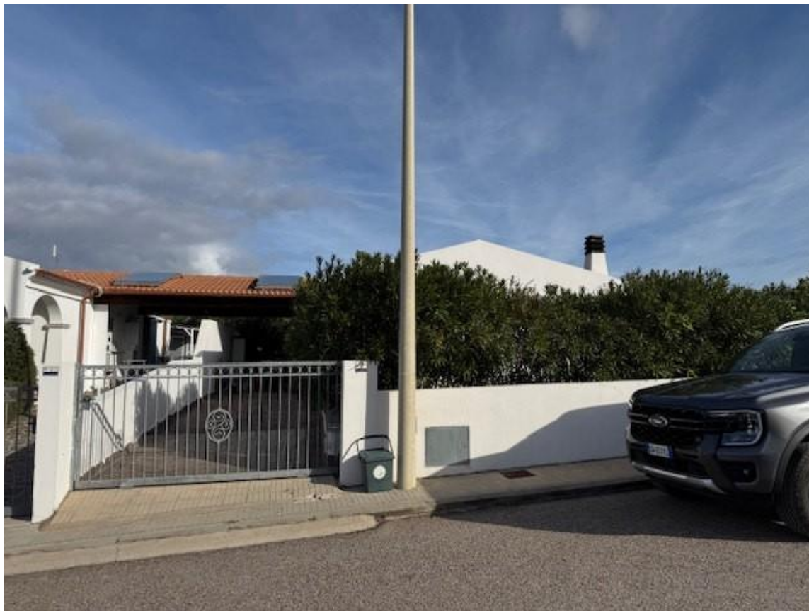
SCATTO DALLA VIA .....PARTICOLARE VISTA INGRESSO CARRABILE E POSTO AUTO COPERTO
