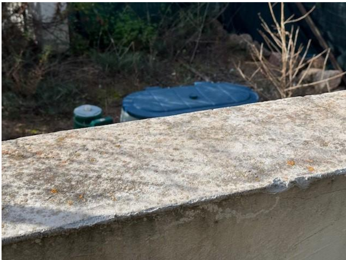
VISTA BOMBOLONE DEL GAS POSTO SUL SUB ... IN COMPROPRIETA' CON IL SUB ....
