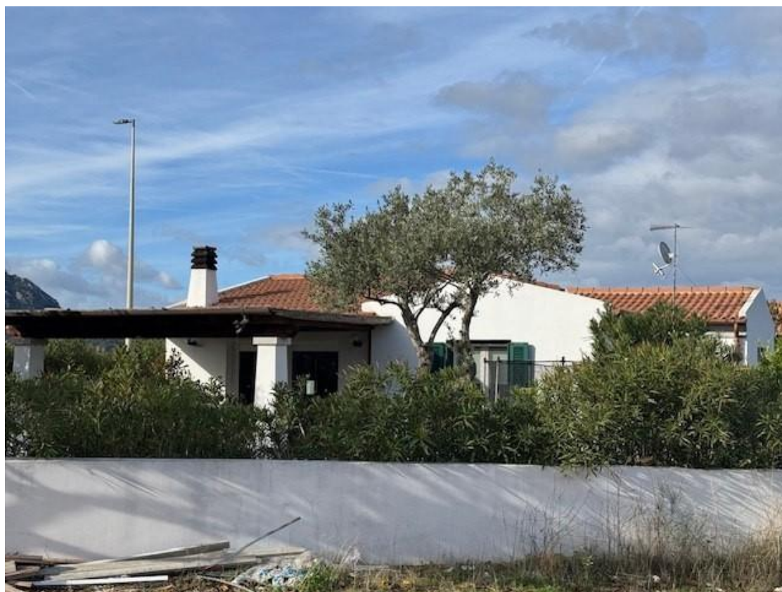
SCATTO DALLA VIA ..... PARTICOLARE VISTA PROSPETTO PRINCIPALE
