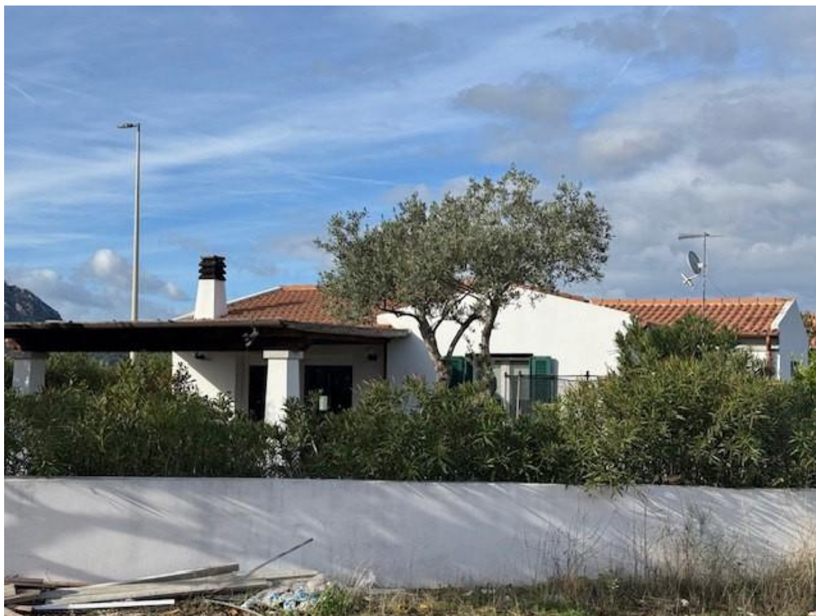
SCATTO DALLA VIA NELSON MANDELA VISTA PROSPETTO PRINCIPALE
