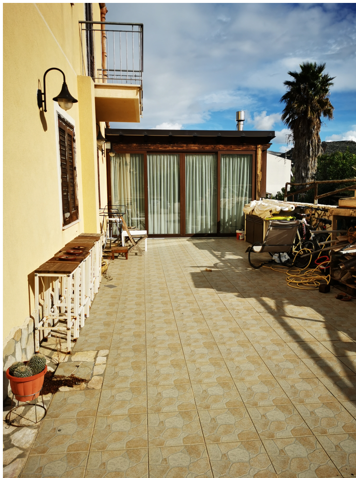
Laterale con sfondo ampliamento tettoia
