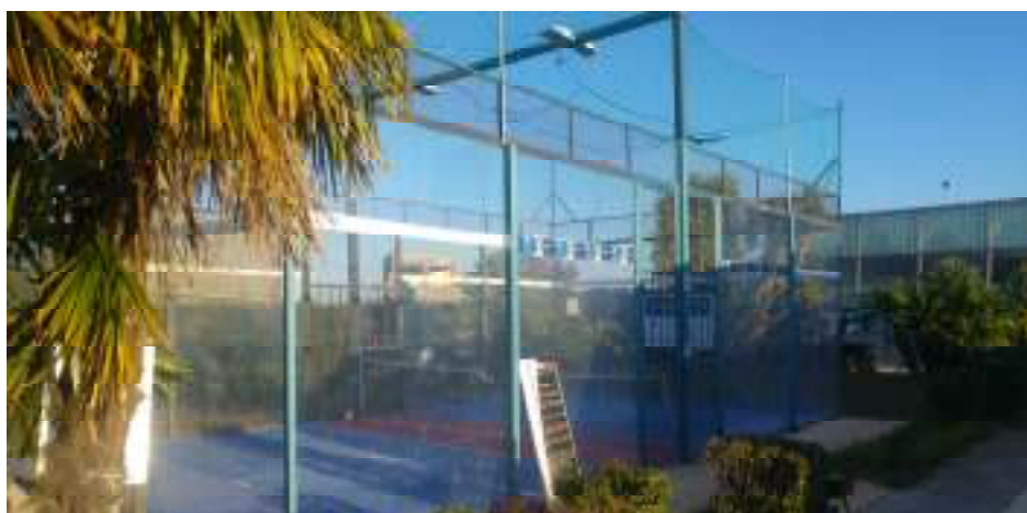
FOTO 4 - CENTRO BENESSERE (Vista campo polivalente esterno)
