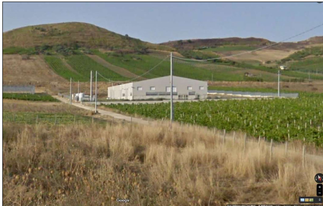
Immagine storica dell'immobile pignorato tratta da Google Street View, con data di acquisizione agosto 2010, da cui si evidenzia uno stato del complesso industriale identico a quello attualmente rinvenuto
