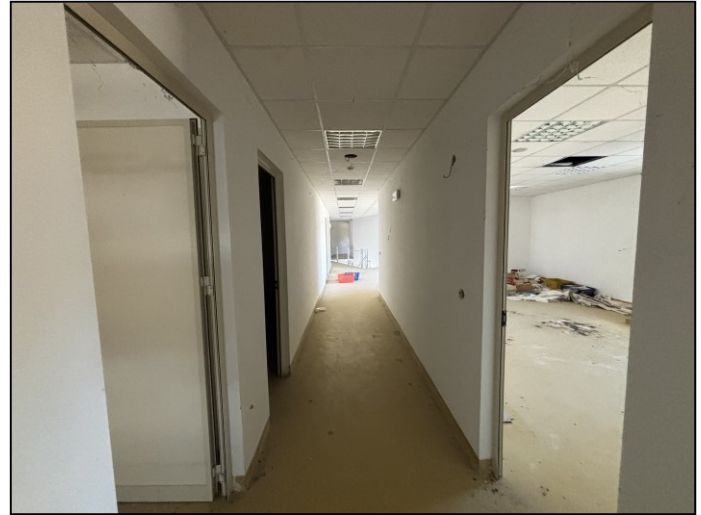
Zona direzionale: disimpegno 4
