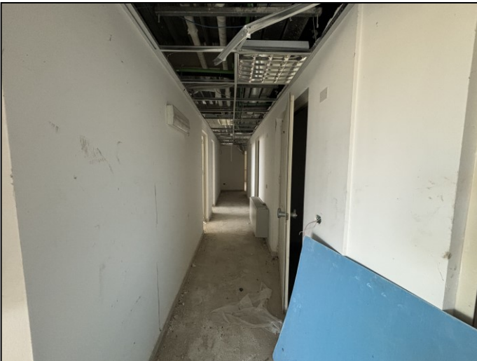
Zona ricevimento e servizi: disimpegno 3
