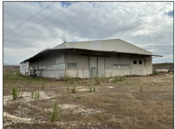
Capannone: veduta dei prospetti sud e ovest
