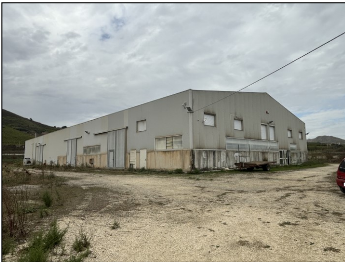
Capannone: veduta dei prospetti nord ed est
