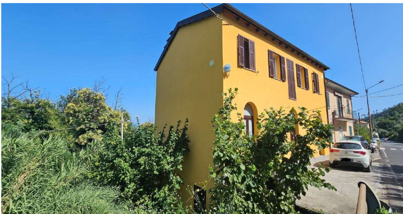
Foto n°4. Panoramica, fronte strada, lato Nord-Ovest,
