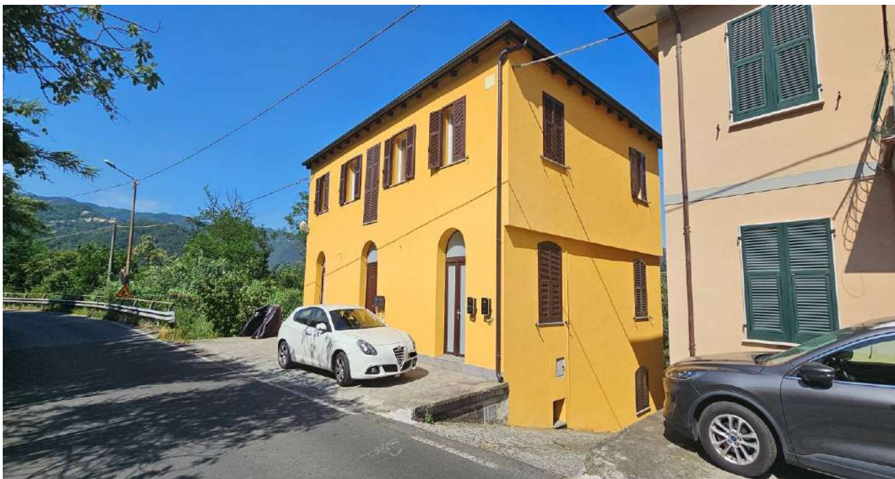
Foto n°1. Panoramica, fronte strada, lato Sud-Ovest,
