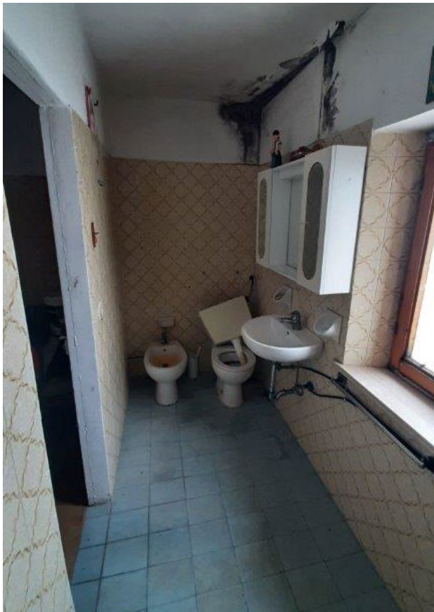
Foto 24 – Vista del bagno al piano terra.
