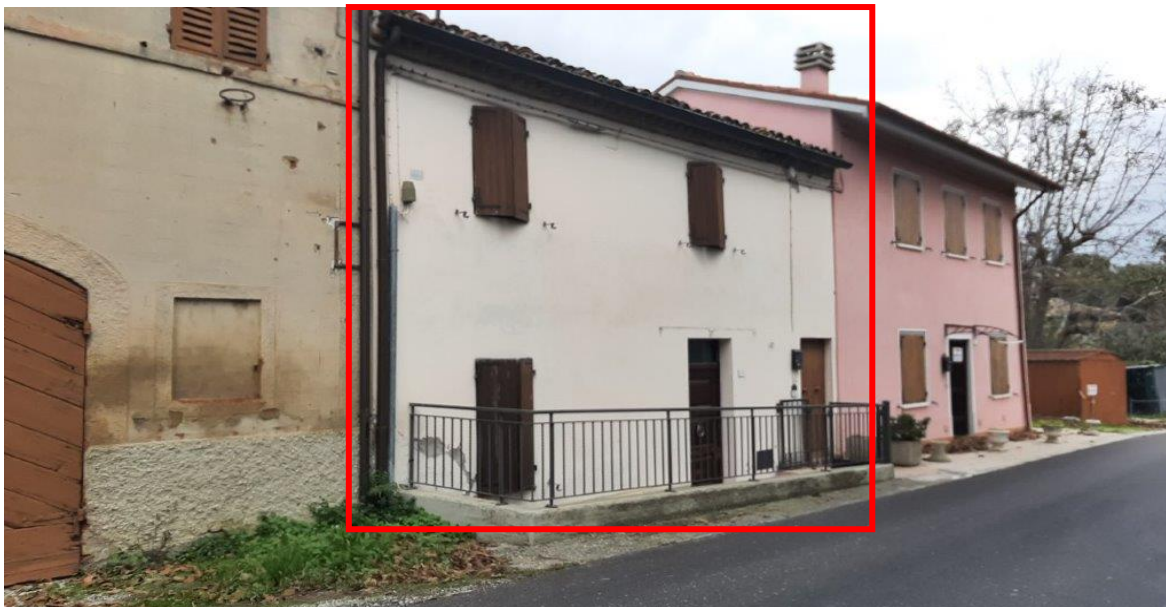
Foto 4 – Vista del prospetto principale del corpo di fabbrica dalla strada pubblica, con indicazione della porzione di fabbricato oggetto di perizia, ubicato in via della Pieve n. 39.
