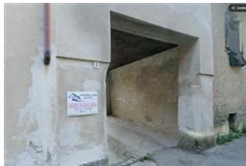
androne d'ingresso alla corte comune
