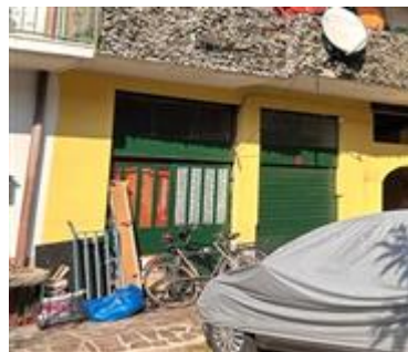
stato dei luoghi al momento della perizia
