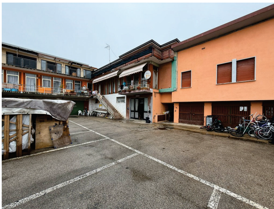
Veduta facciata e scoperto comune
