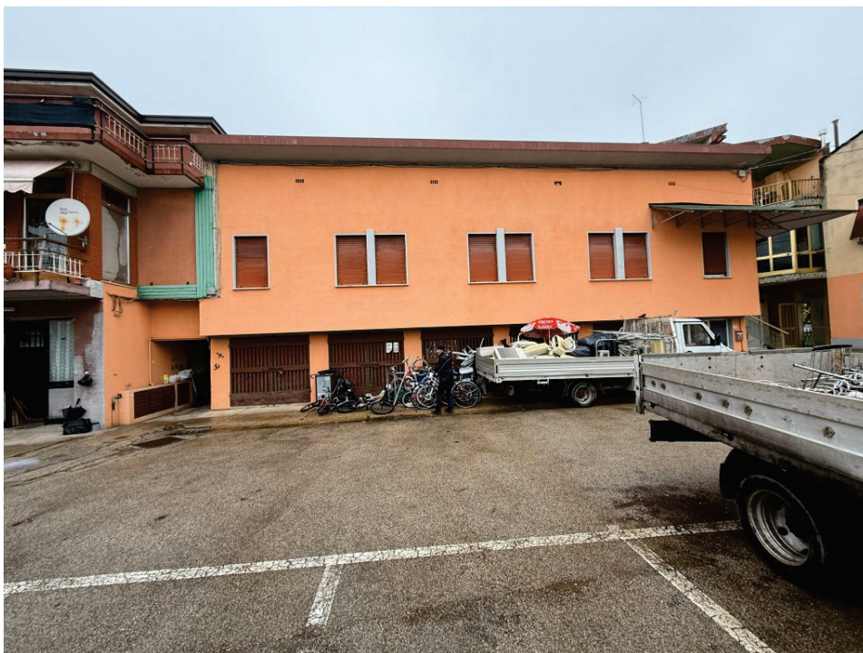
Veduta facciata e scoperto comune
