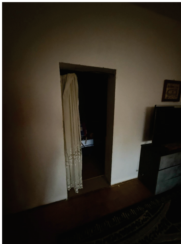
Veduta foro accesso da camera a ripostiglio
