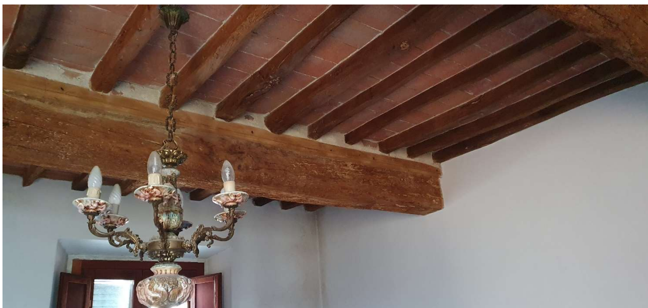
35 PARTICOLARE SOFFITTO CAMERA MATRIMONIALE
