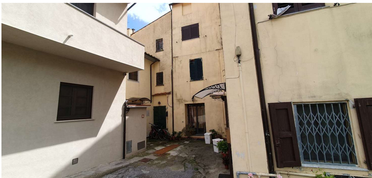
04 VISTA FABBRICATI ADIACENTI
