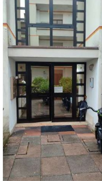
FOTO 2: vista vano scala comune
