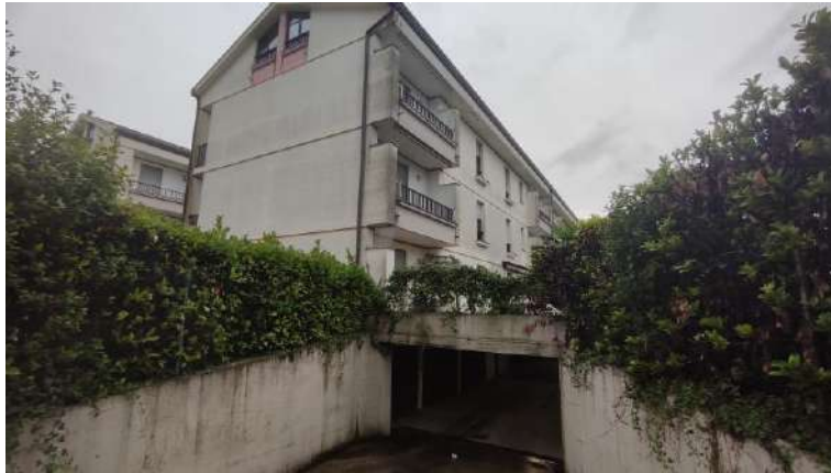
FOTO 4: vista prospetto sud-ovest
