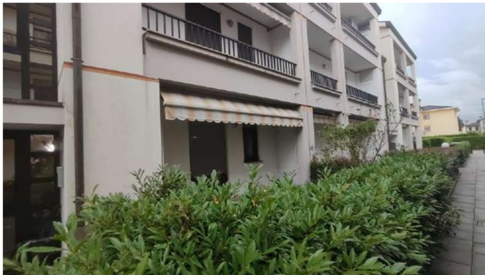
FOTO 3: vista prospetto nord
