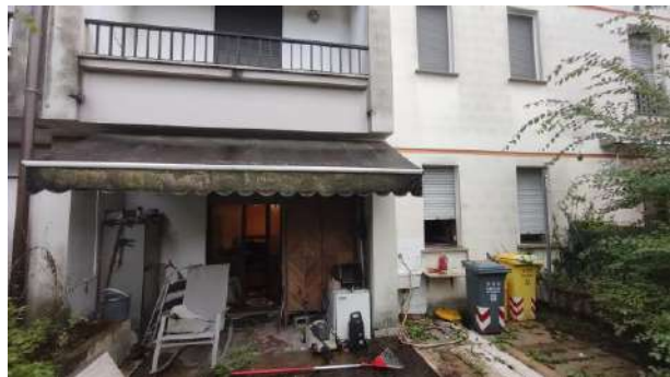
FOTO 14: vista prospetto sud
