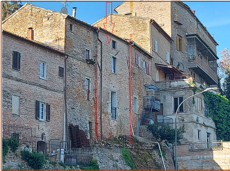
Foto Esterna N. 2 -Prospetto Nord
