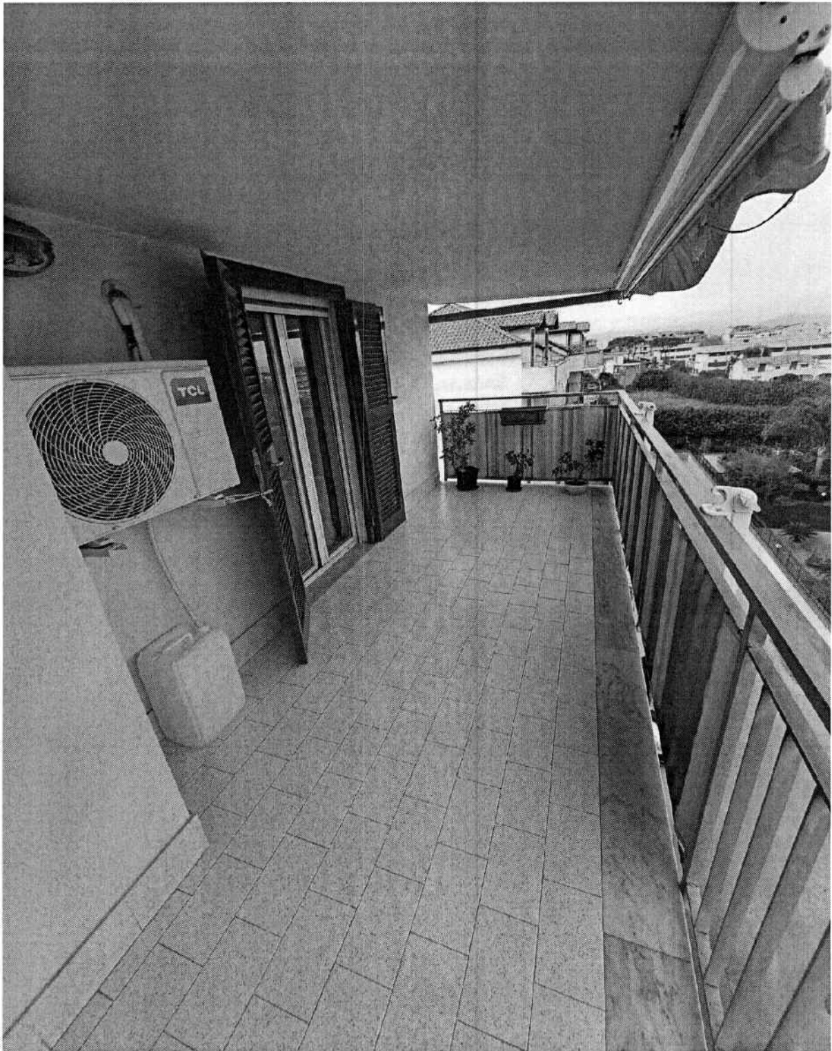
Balcone Lato Est
