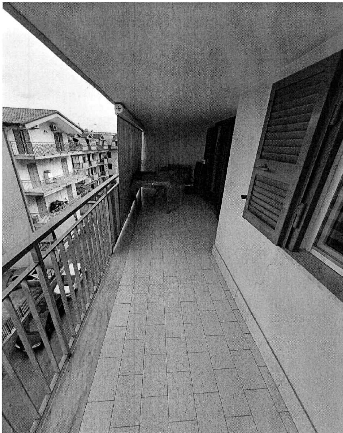
Balcone Lato Est
