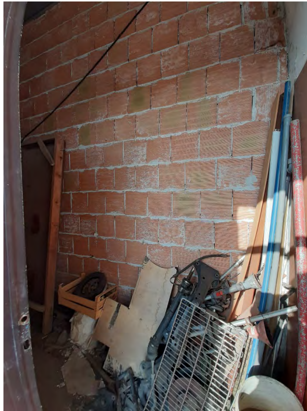
Foto 20: Vista locale tecnico
