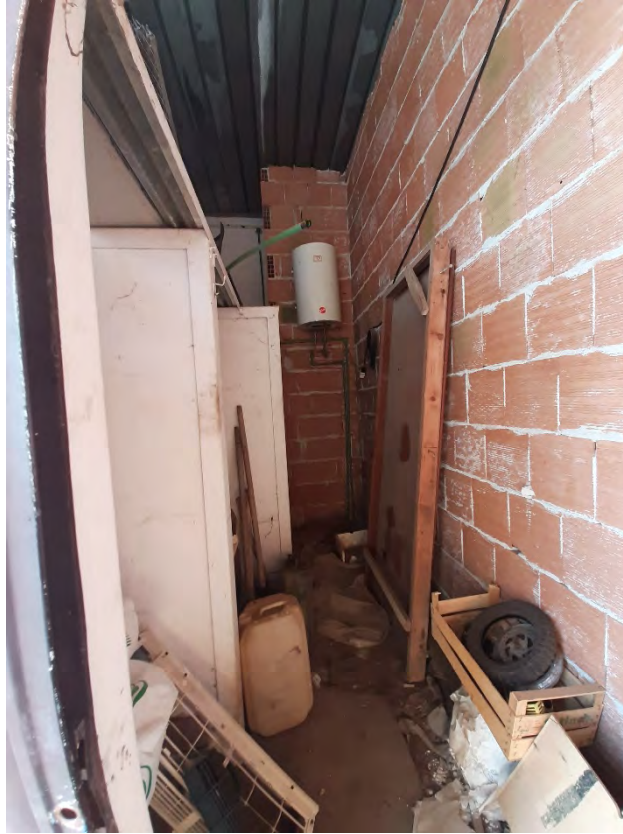
Foto 19: Vista locale tecnico
