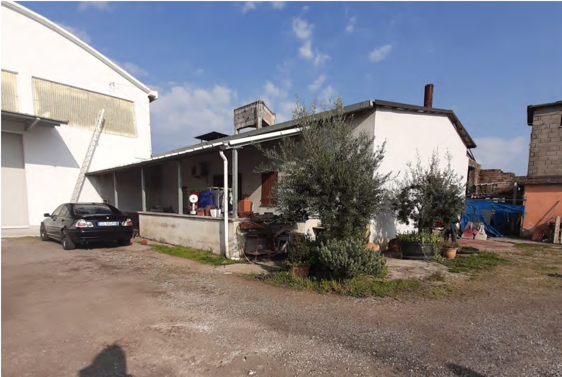
Foto 1: Vista prospetto intero edificio
