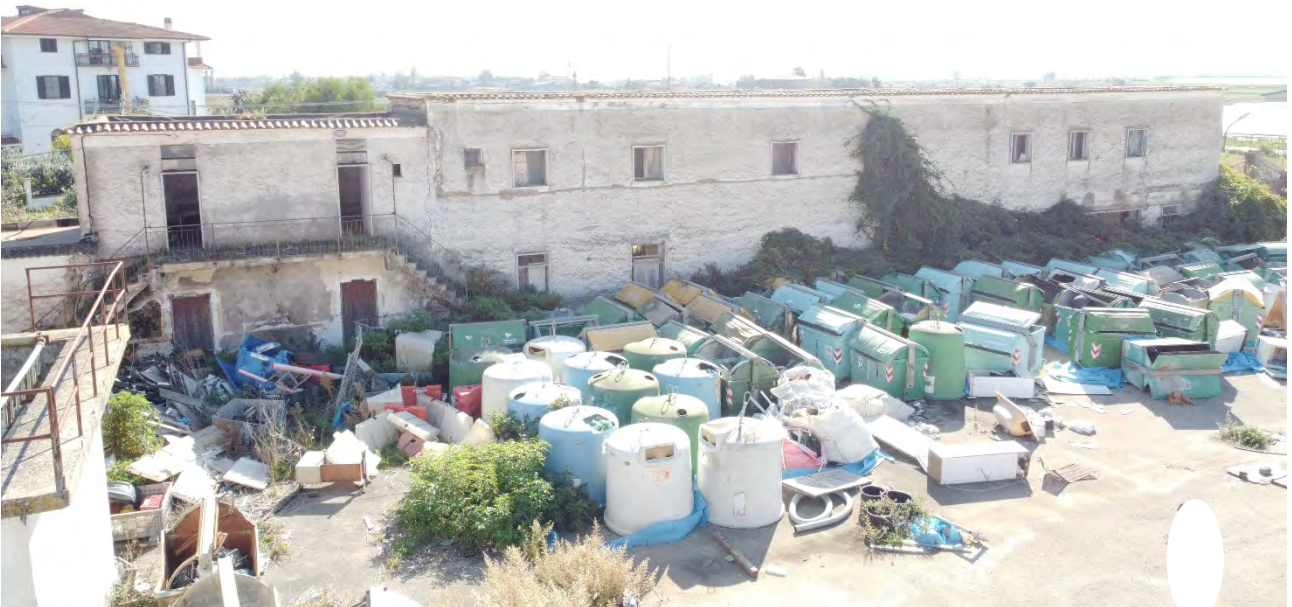
Foto 2: Vista prospetto frontale intero edificio da corte interna
