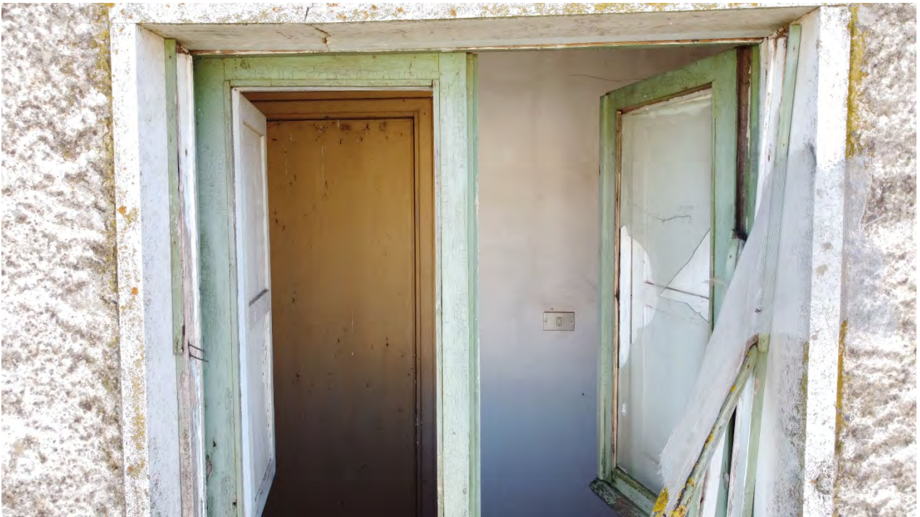
Foto 4: Vista interno edificio
