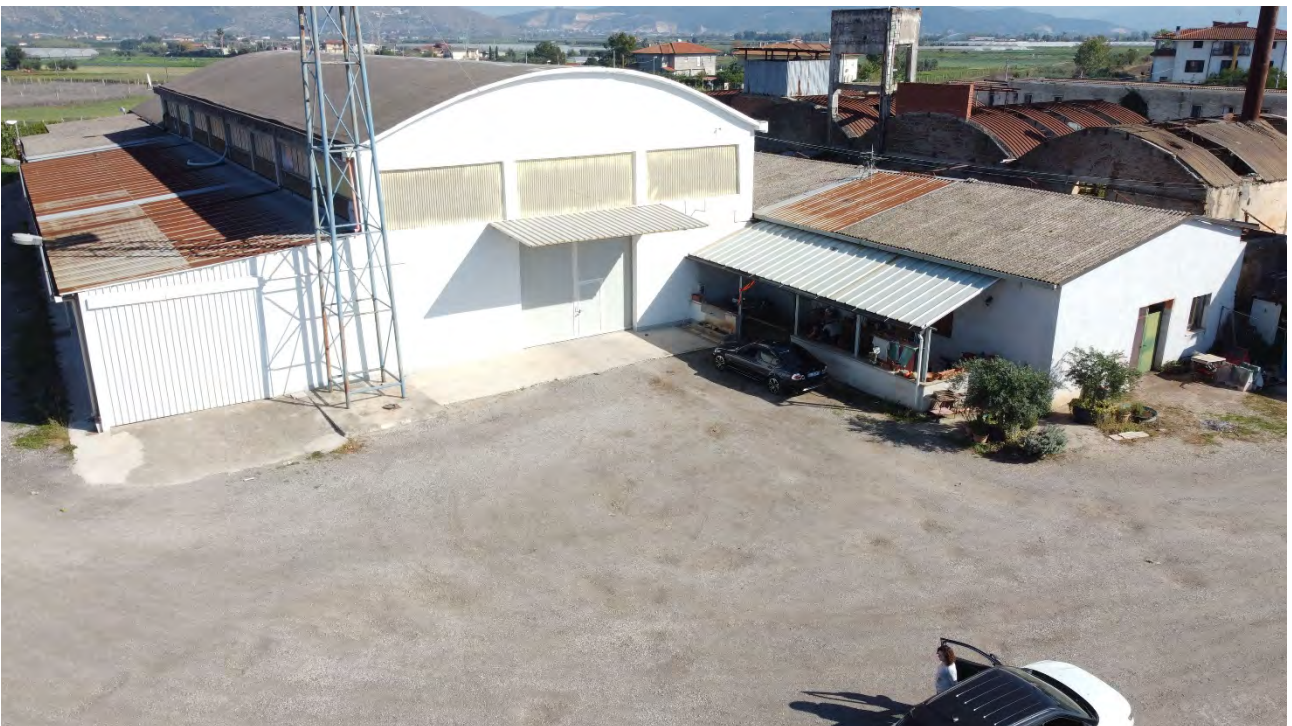
Foto 2: Vista prospetto frontale ingresso fabbricato
