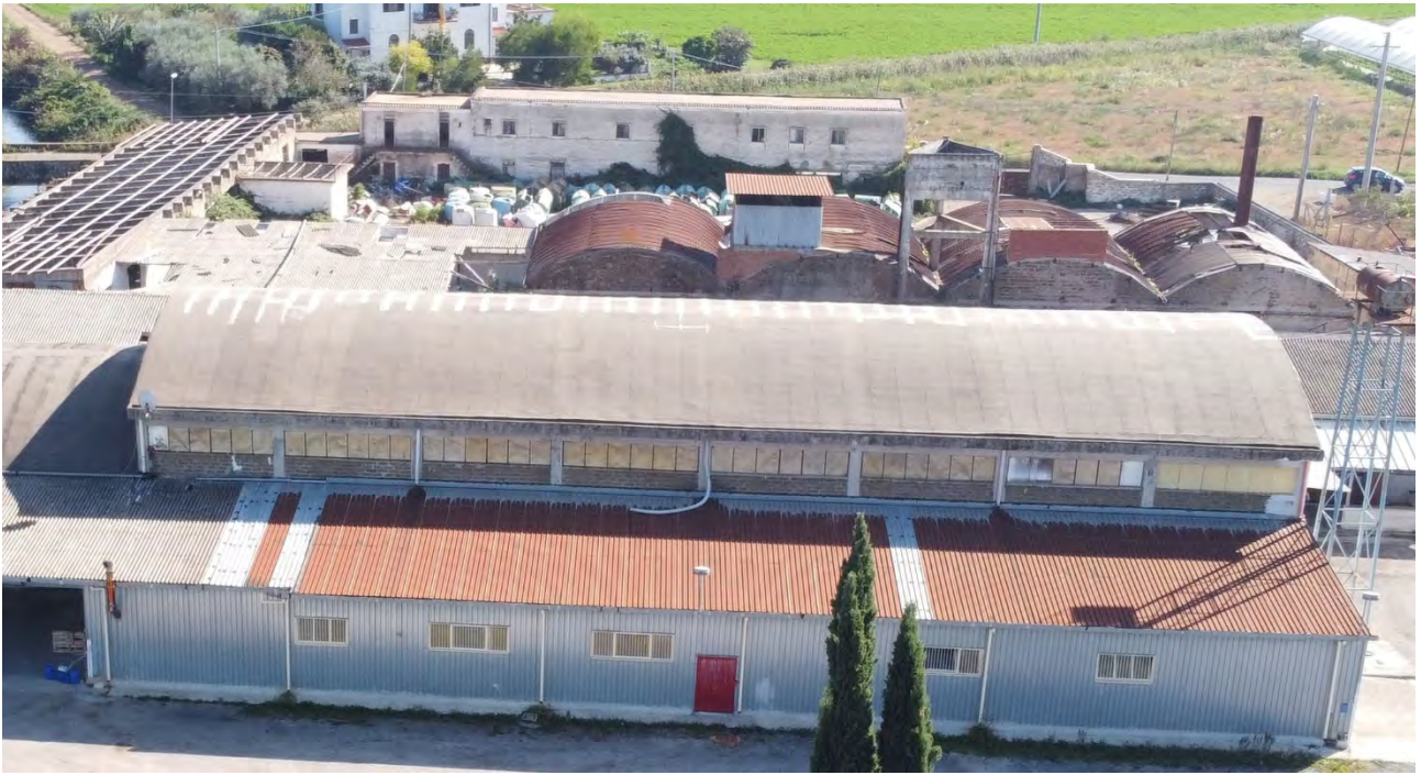
Foto 3: Vista prospetto fabbricato
