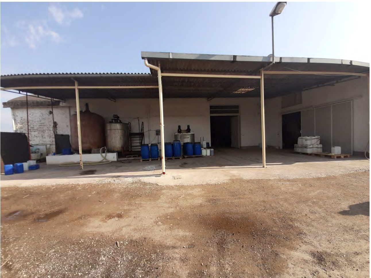
Foto 2: Vista prospetto frontale ingresso e tettoia
