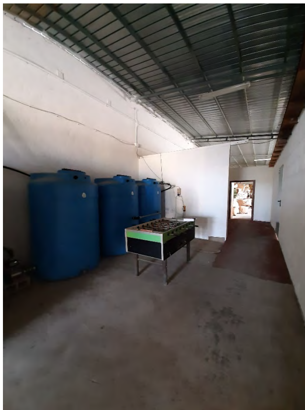
Foto 15: Vista zona serbatoi
