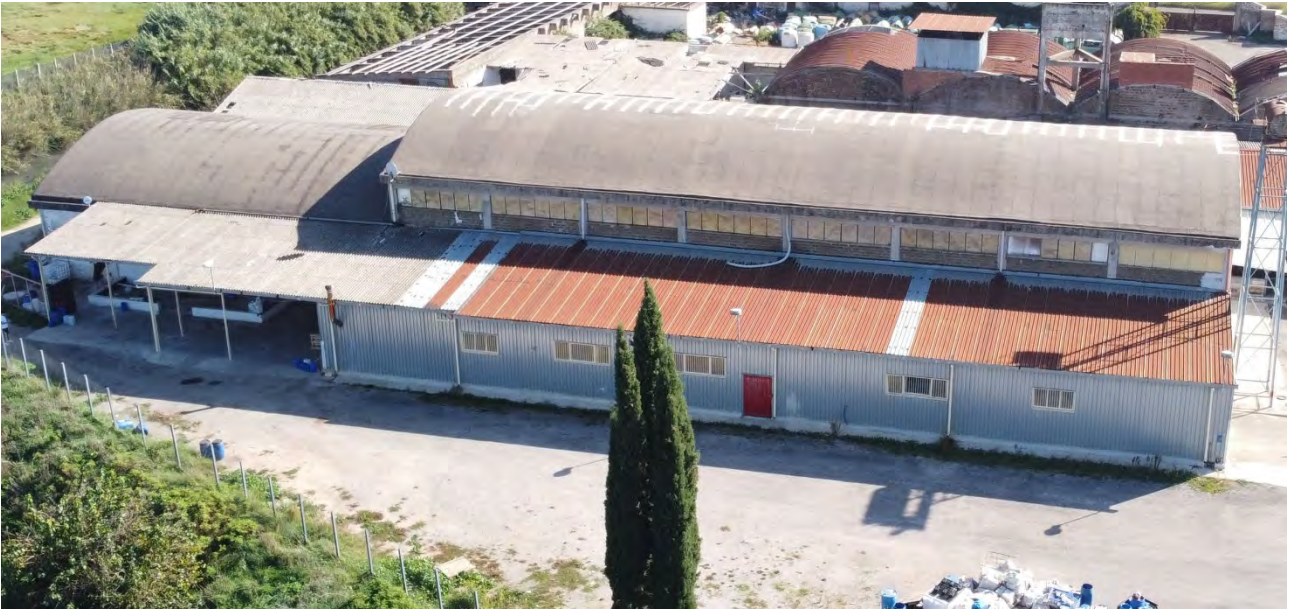
Foto 1: Vista d'insieme edificio dall'alto
