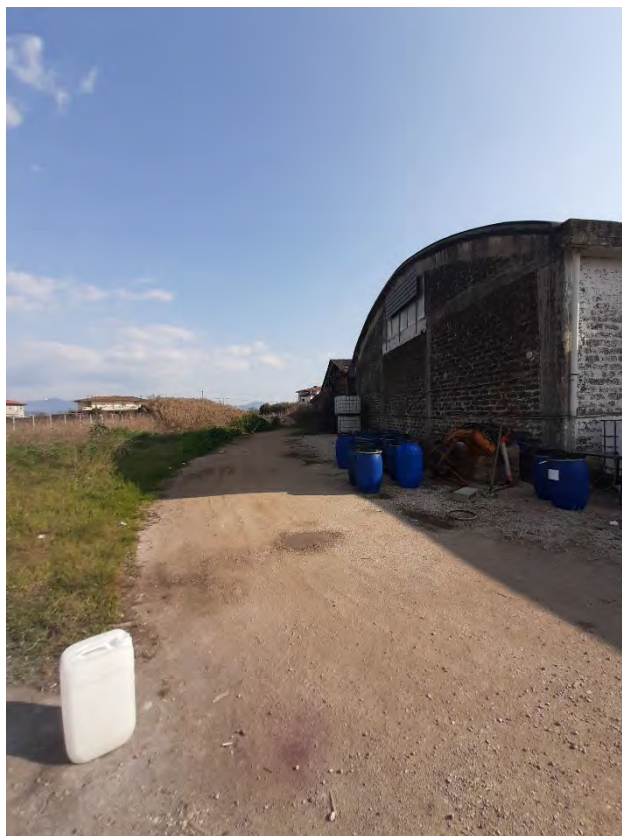
Foto 3: Vista prospetto retro
