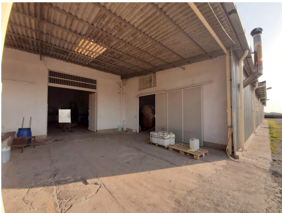
Foto 4: Vista ingressi edificio
