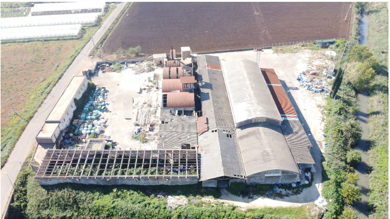
Foto 4: Vista dall'alto corte e fabbricati da lato
