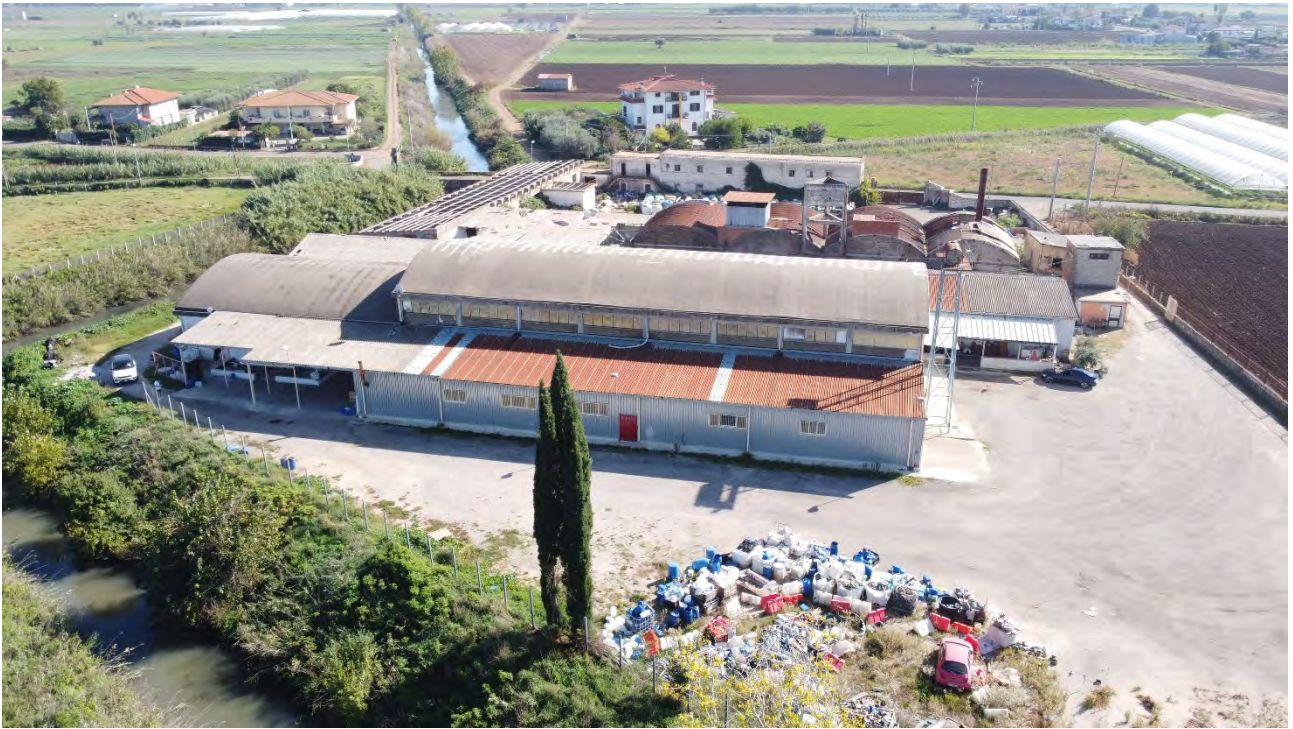
Foto 3: Vista dall'alto corte e fabbricati da retro
