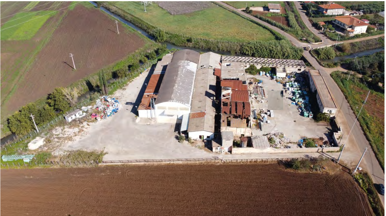
Foto 2: Vista dall'alto corte e fabbricati da lato
