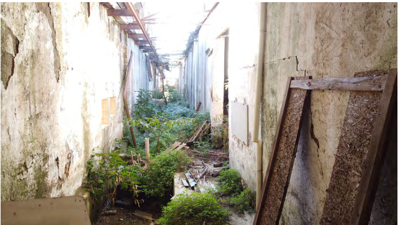
Foto 18: particolare zona interna
