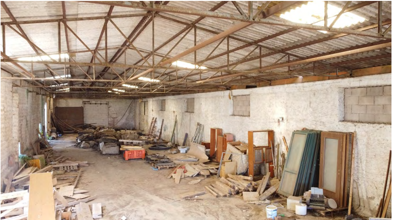
Foto 16: particolare zona interna
