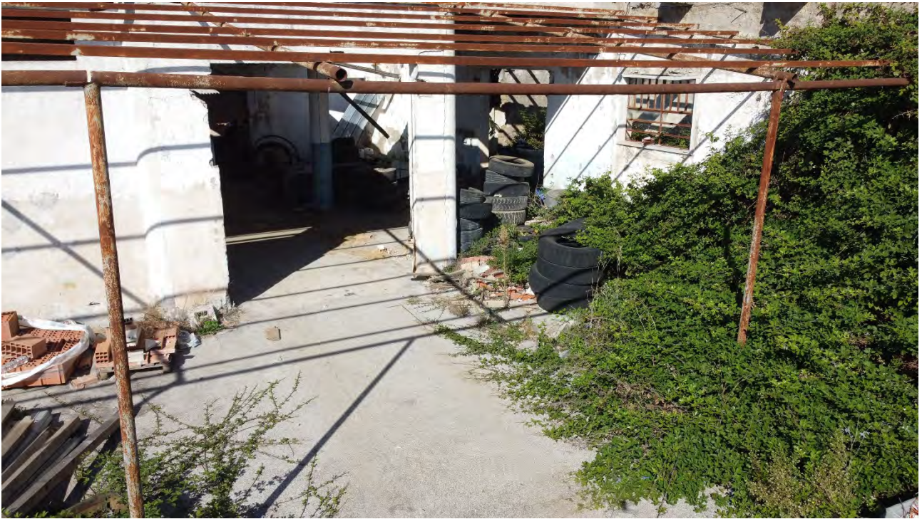
Foto 9: Vista particolare ingresso
