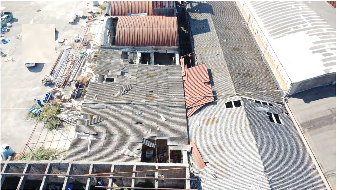
Foto 5: Vista dall'alto copertura porzione fabbricato
