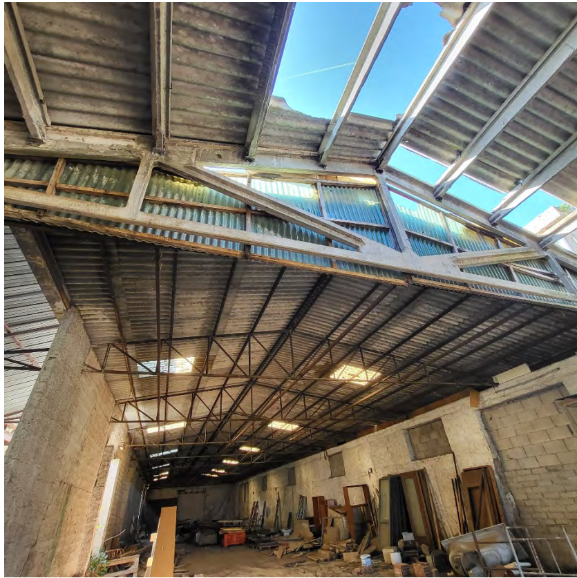
Foto 17: particolare zona interna e copertura
