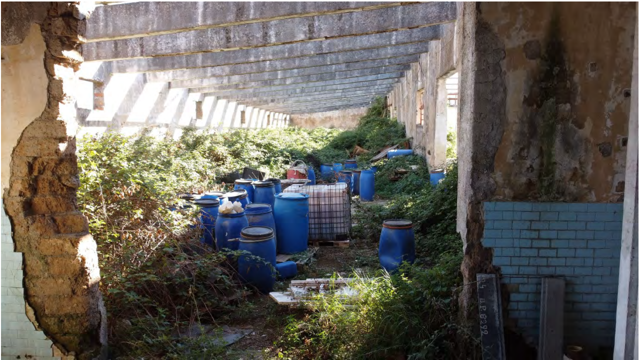
Foto 19: Vista particolare zona interna
