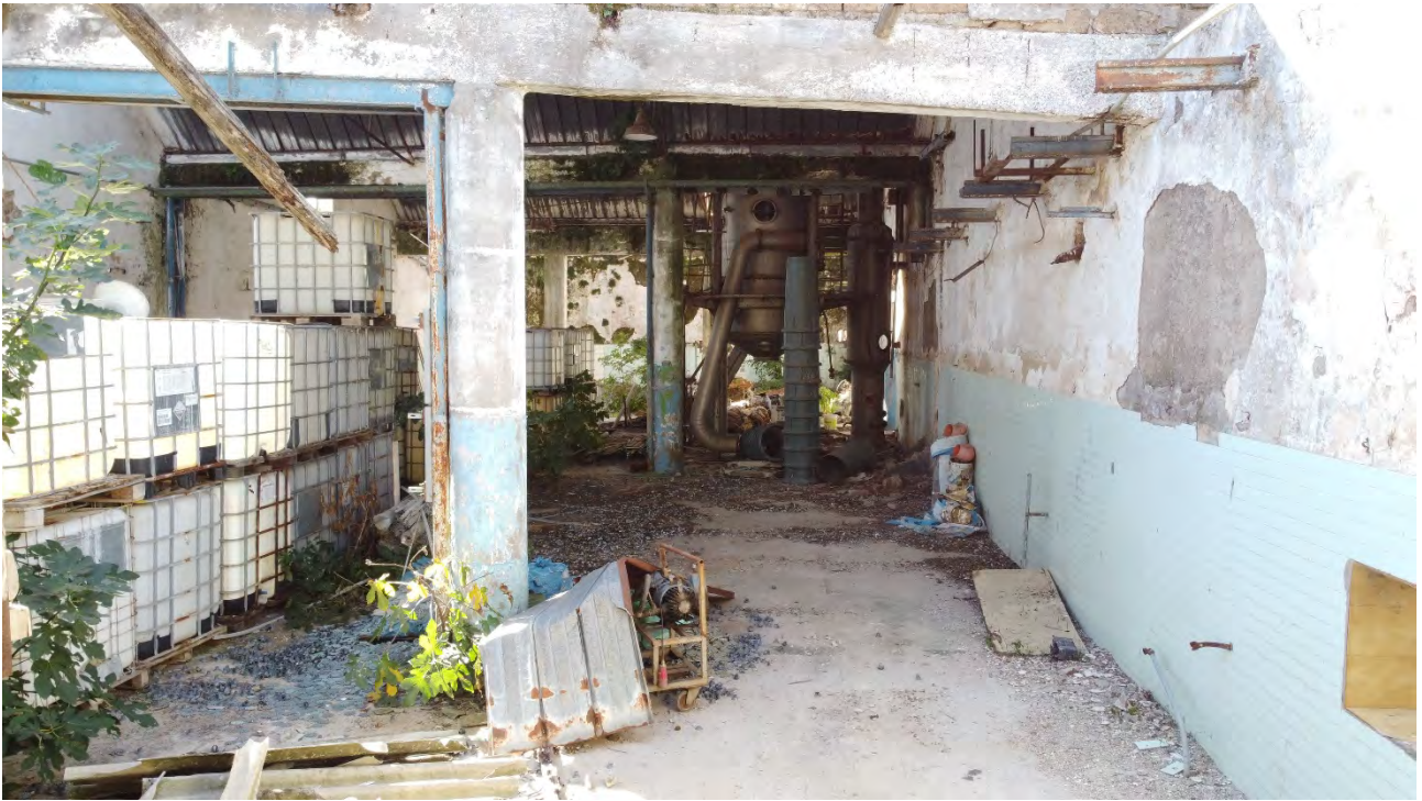
Foto 13: particolare zona interna
