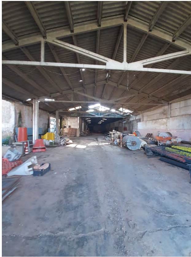
Foto 15: particolare zona interna
