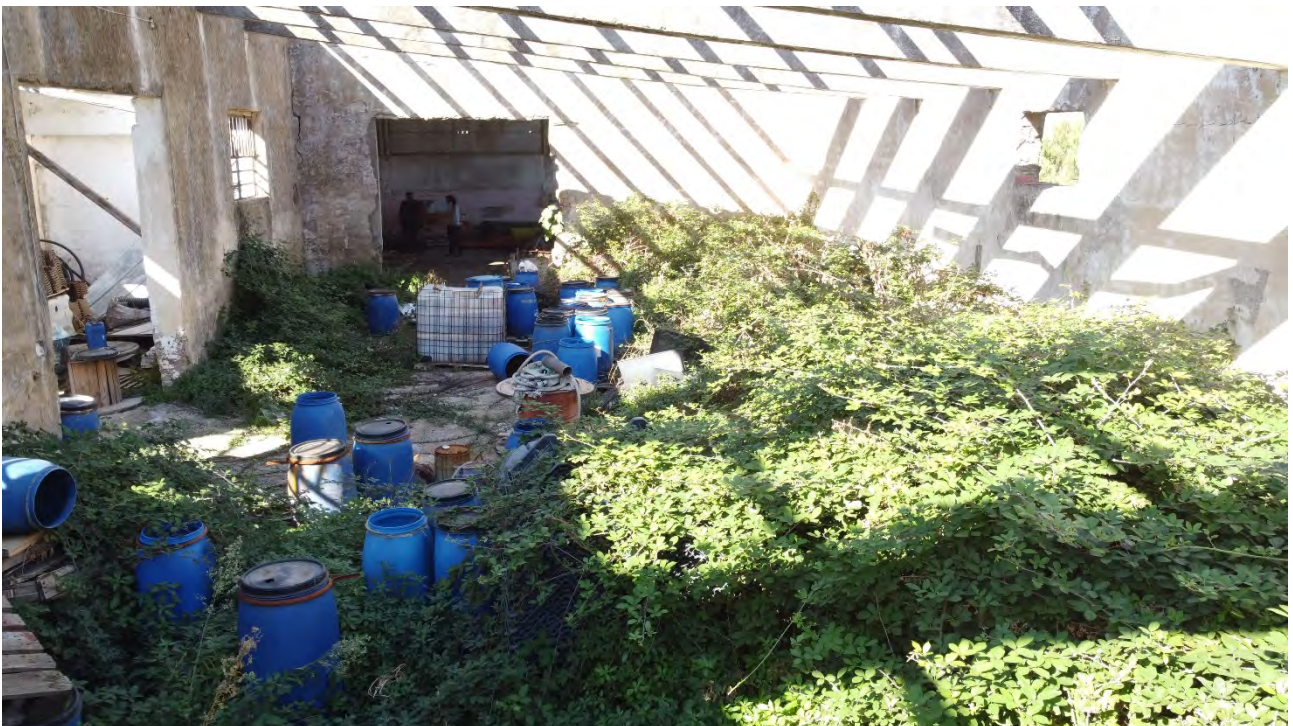
Foto 20: particolare zona interna
