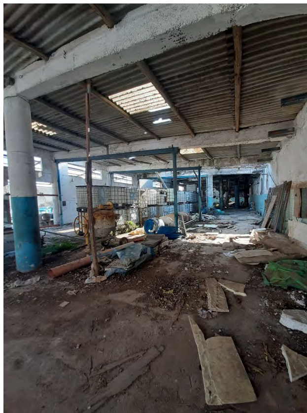
Foto 14: particolare zona interna
