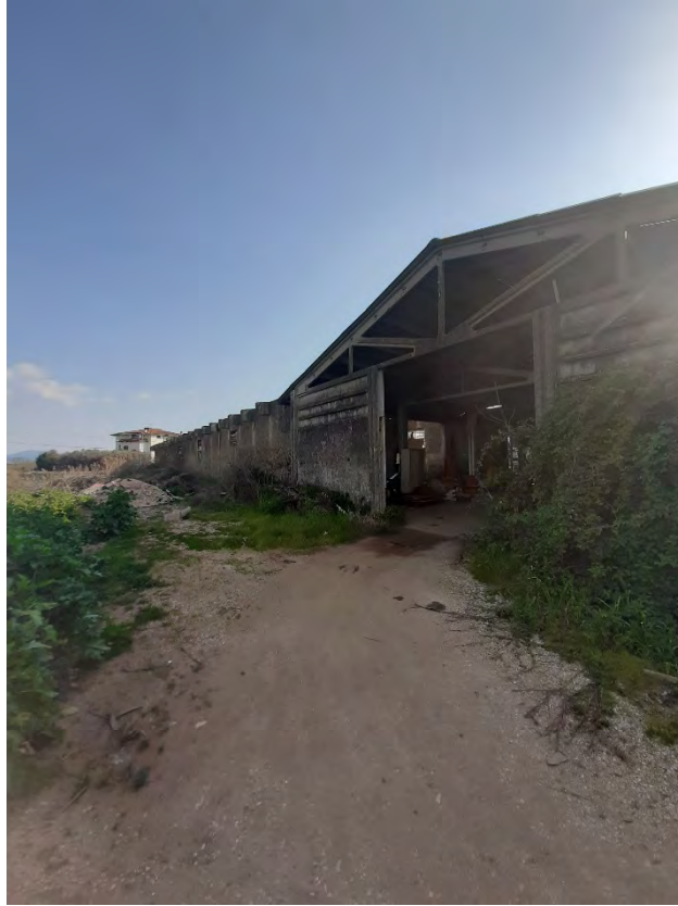
Foto 21: Vista particolare ingresso retro
