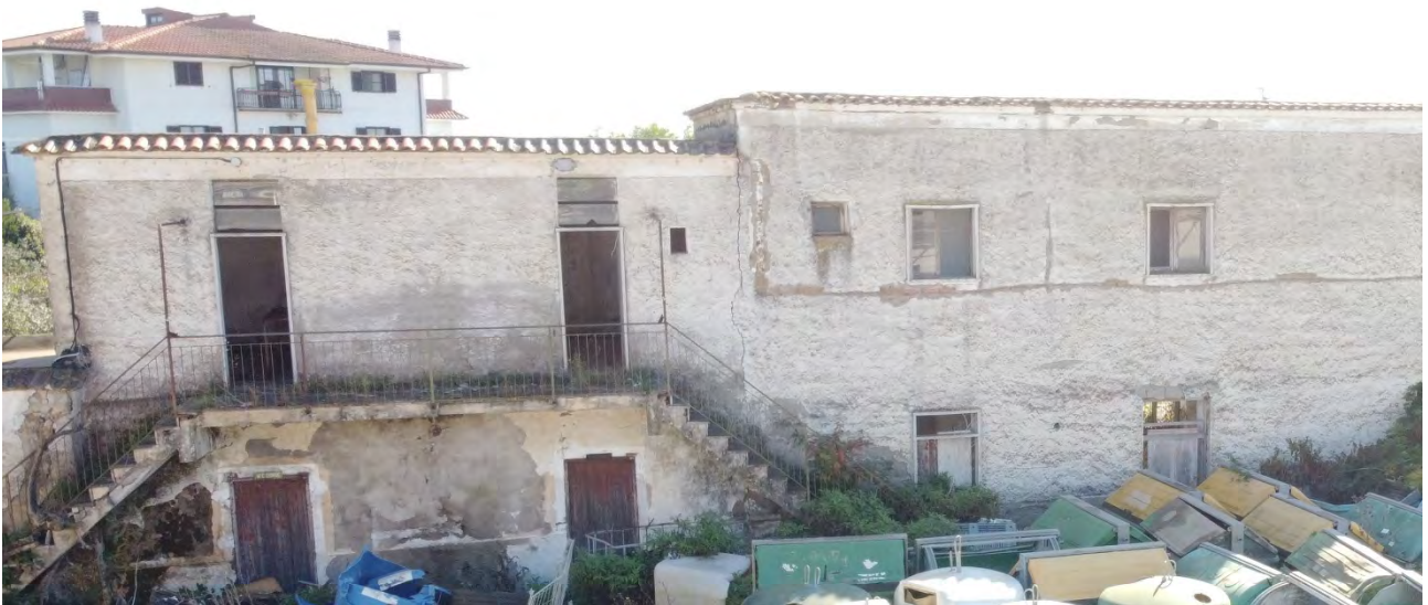
Foto 4: Vista prospetto ingresso
