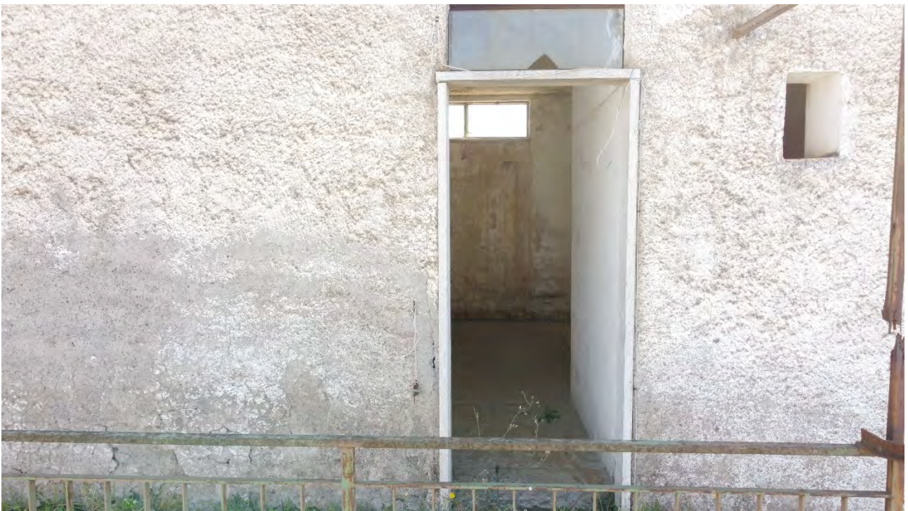
Foto 6: Vista particolare ingresso
