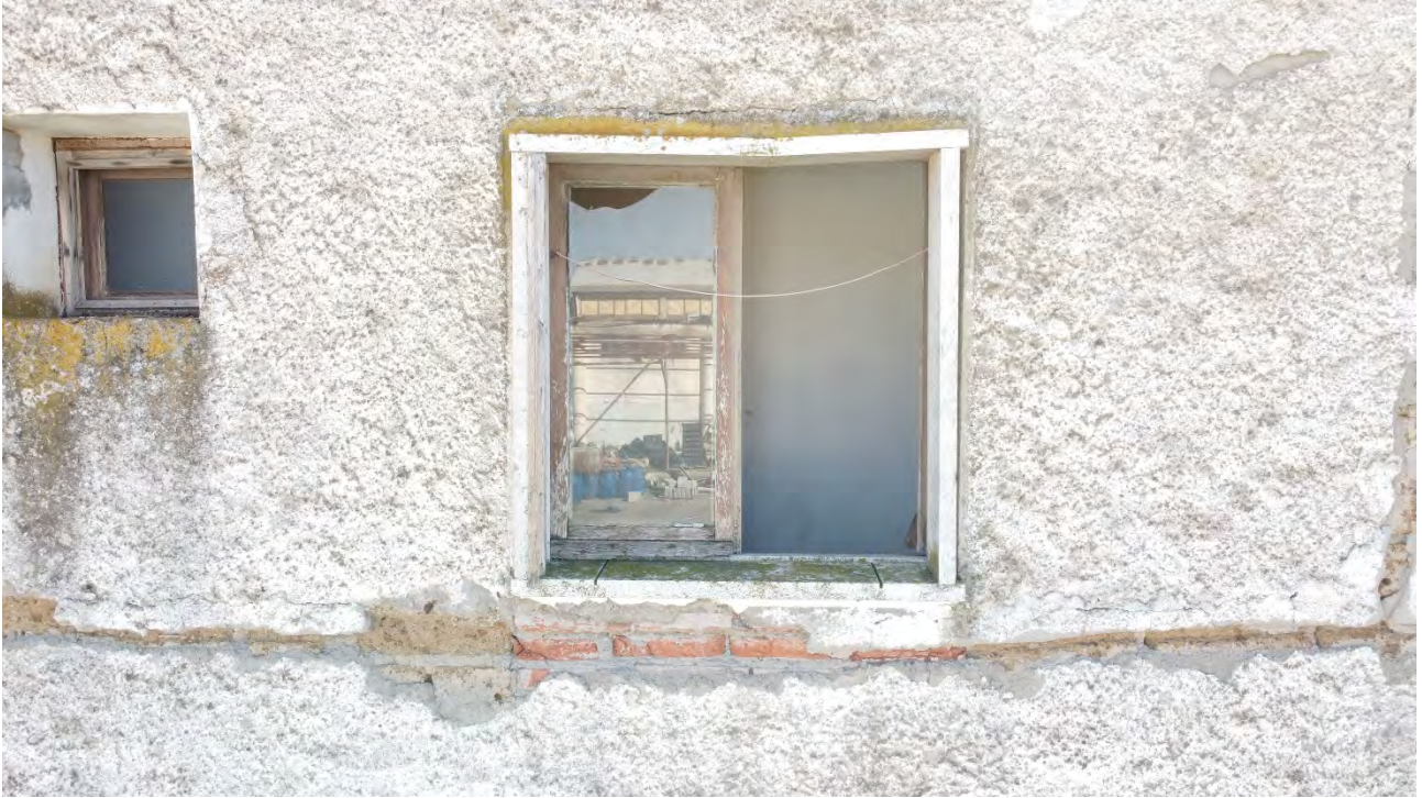
Foto 5: Vista particolare facciata
