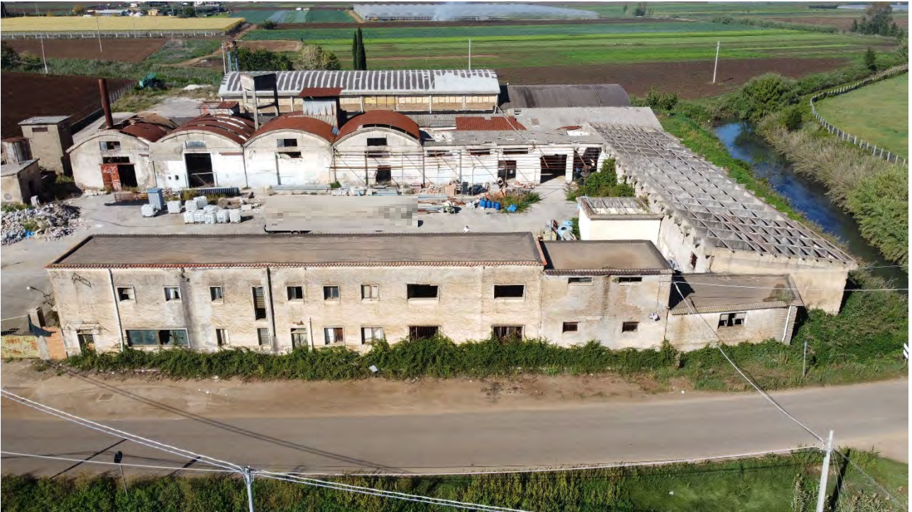
Foto 1: Vista prospetto fabbricato da via Migliara 45
