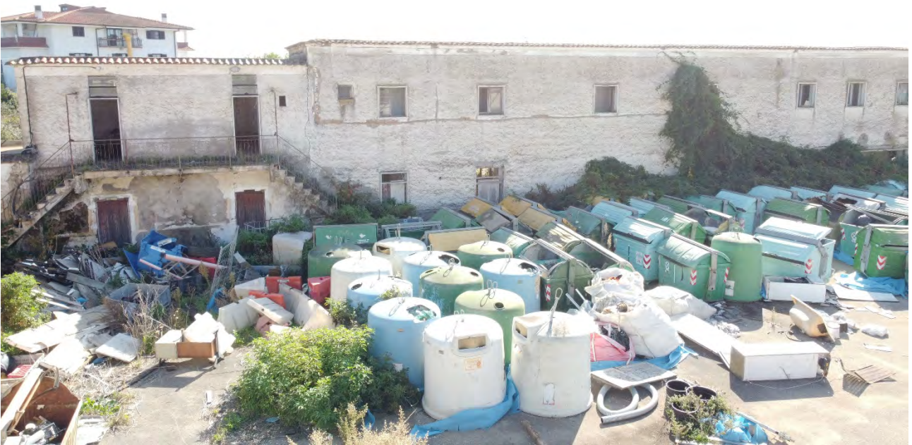
Foto 2: Vista prospetto fabbricato
