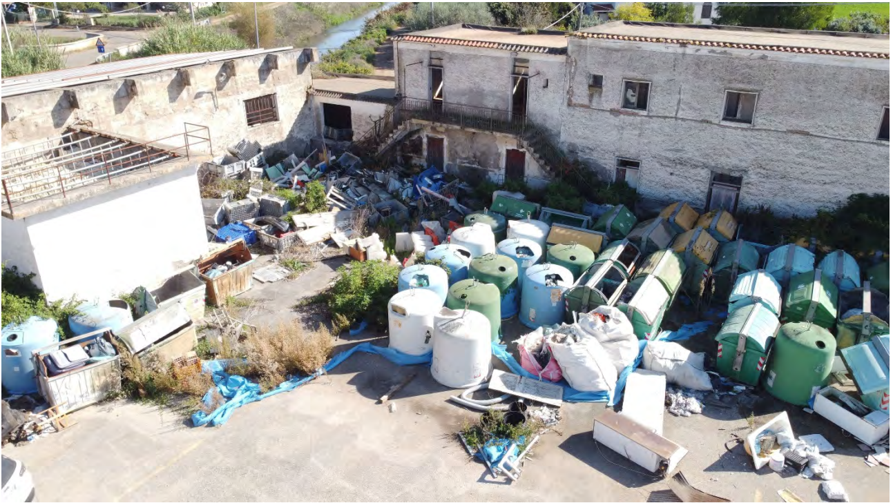
Foto 3: Vista prospetto fabbricato
