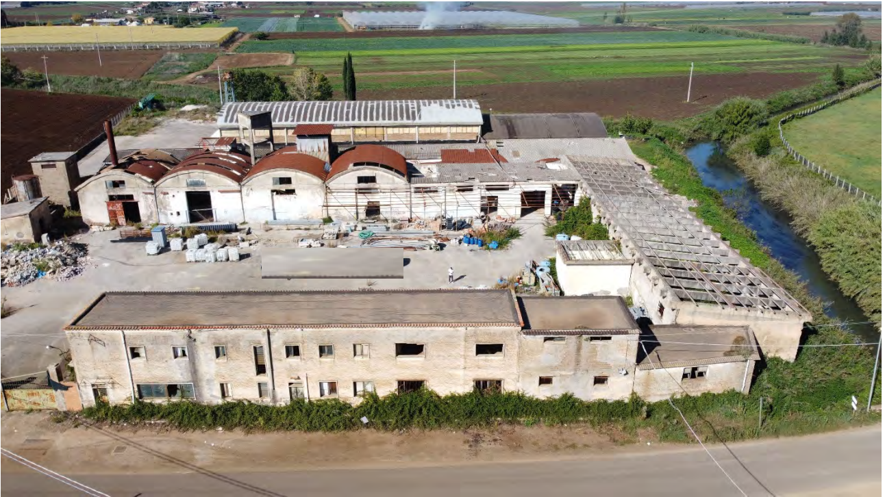
Foto 1: Vista prospetto frontale da via Migliara 45
