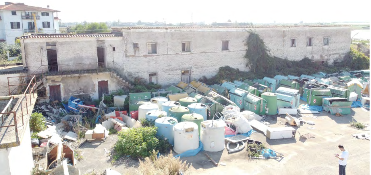
Foto 2: Vista prospetto frontale fabbricato
