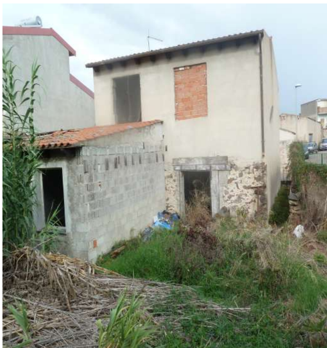
Foto prospetto posteriore con vano abusivo
