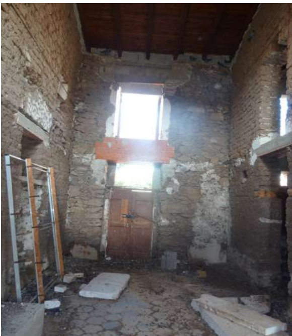
Foto ingresso al vano principale
