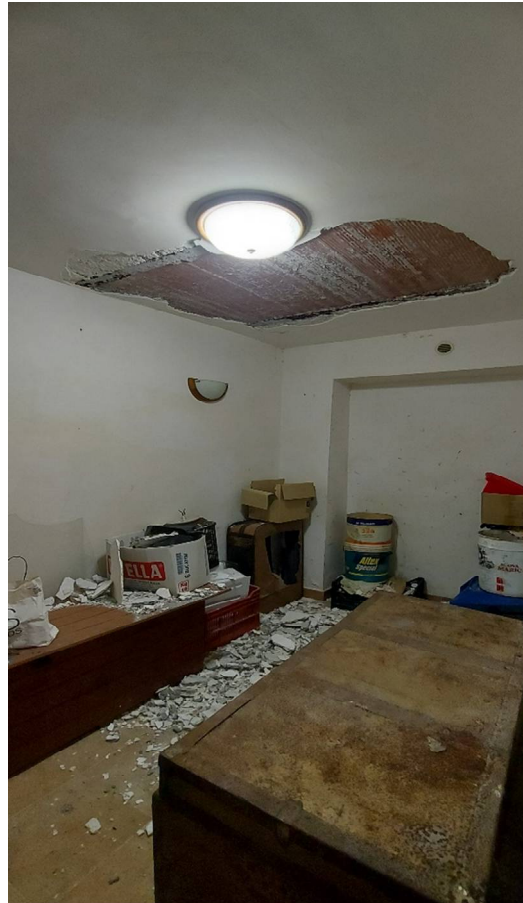
Foto 4 – Ripostiglio piano terra
