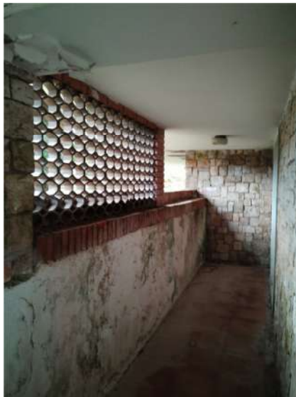
seminterrato accesso cantina
