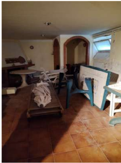
Locale seminterrato cantina /rustico
