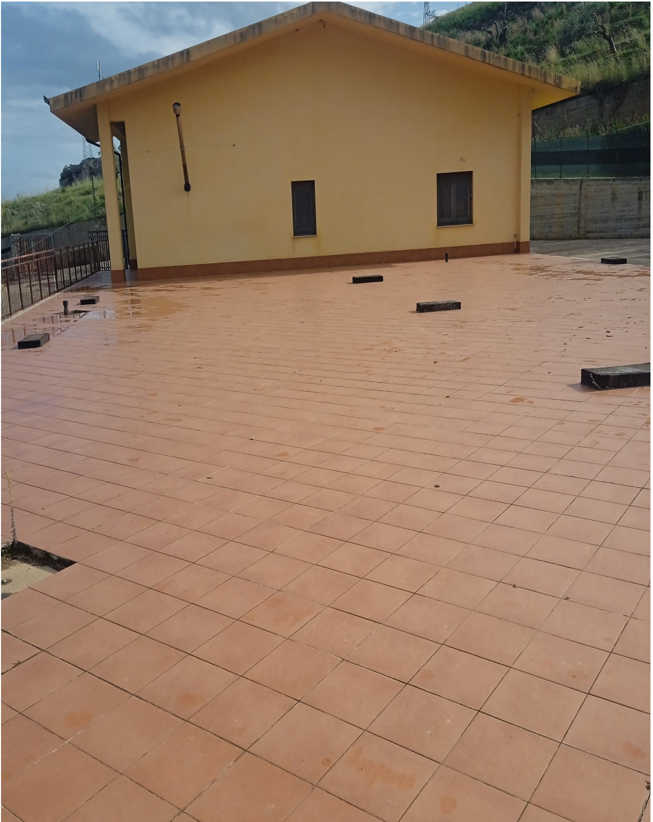
Foto n. 3 Terrazza calpestabile con fabbricato uffici
