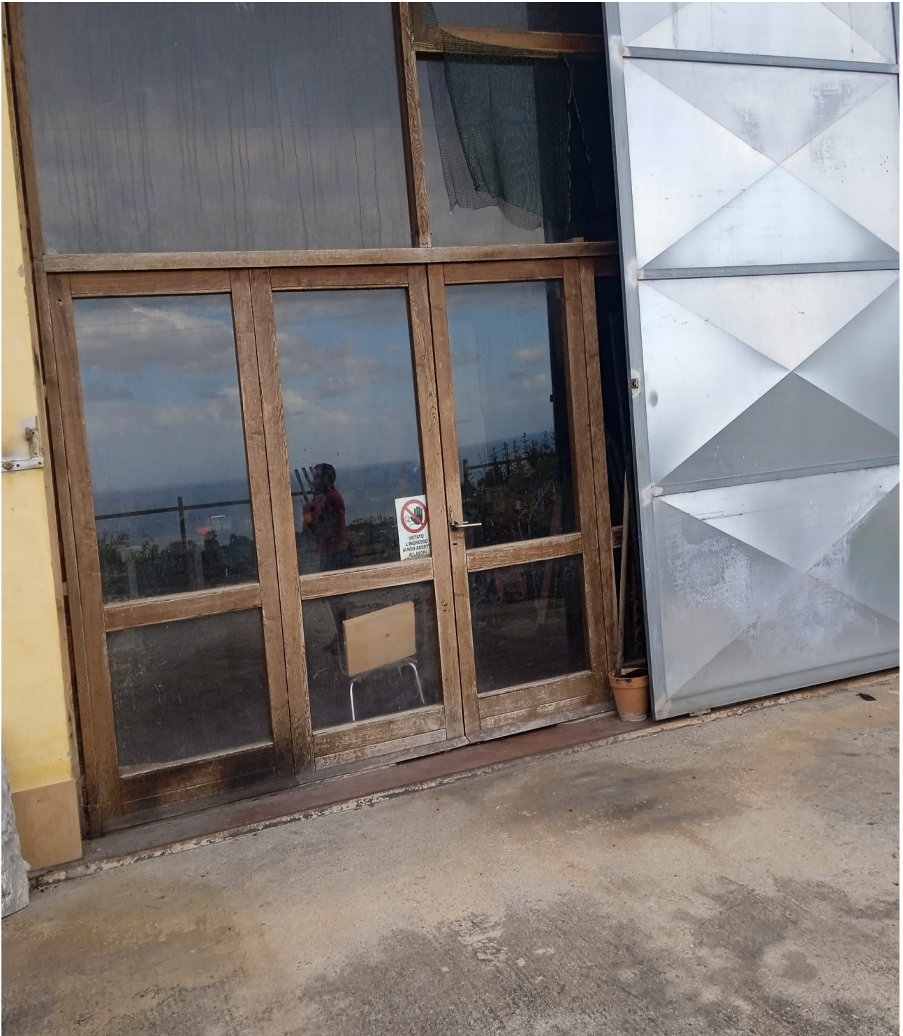
Foto n. 6 Porta ingresso magazzino laboratorio con porta a vetri
