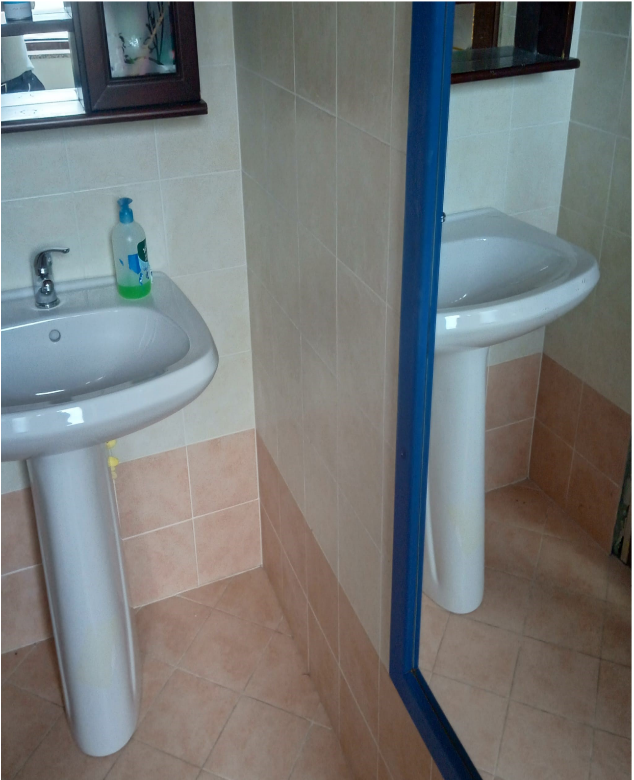
Foto n. 12 bagno interno uffici
