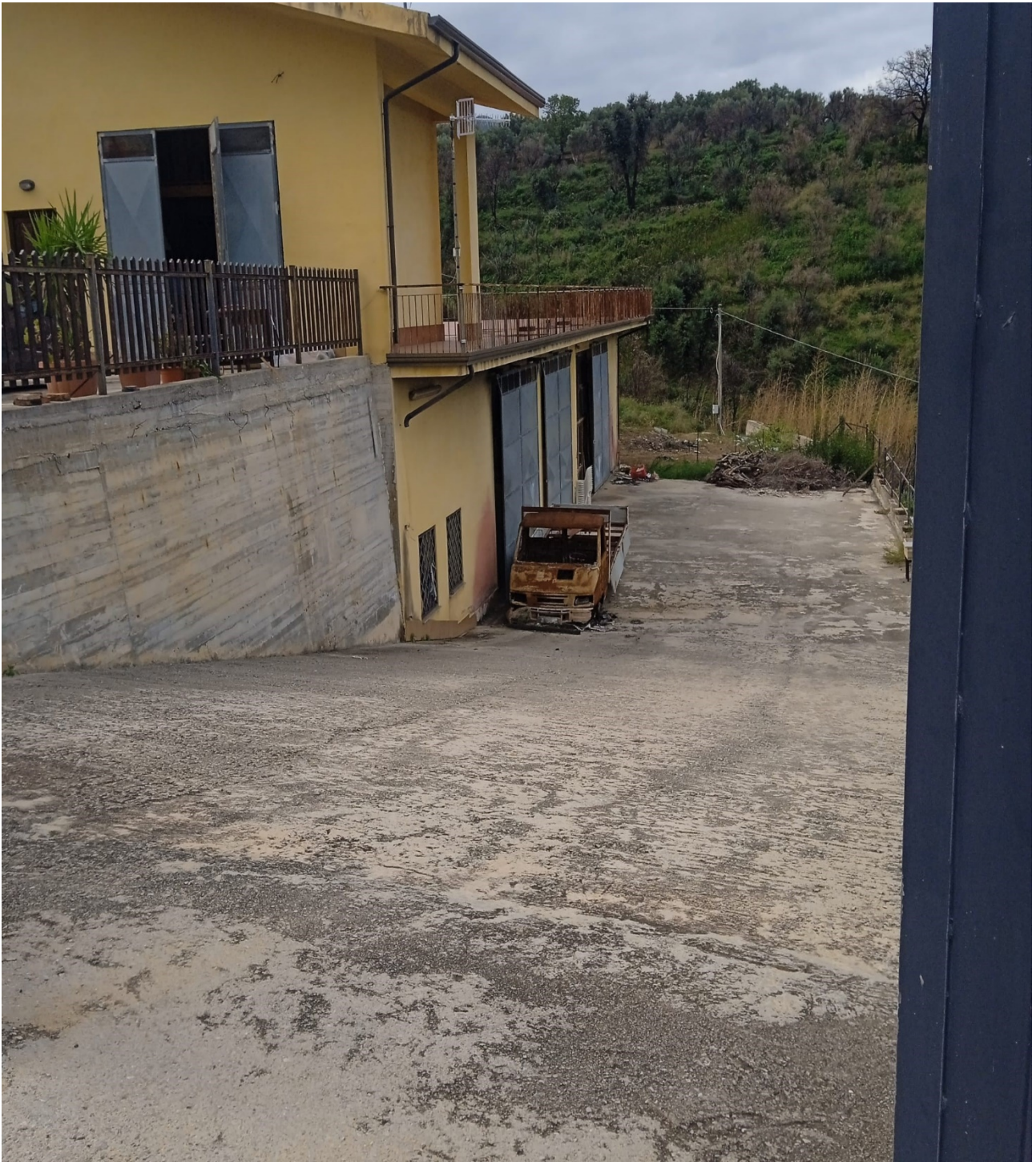
Foto n. 4 strada di accesso al magazzino seminterrato
