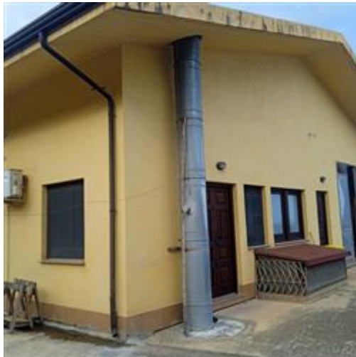
Foto n. 1 Esterno fabbricato lato est
