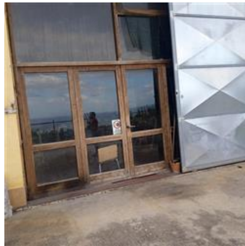
Foto n. 6 Ingresso magazzino con porta a vetri
