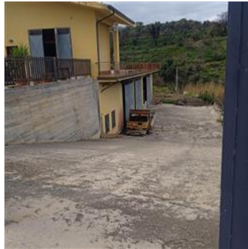
Foto n. 4 Strada di accesso al magazzino seminterrato
