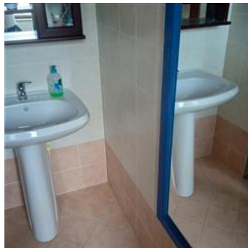
Foto n. 12 bagno interno uffici
