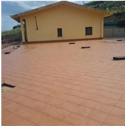
Foto n. 3 terrazzo con fabbricato Uffici
