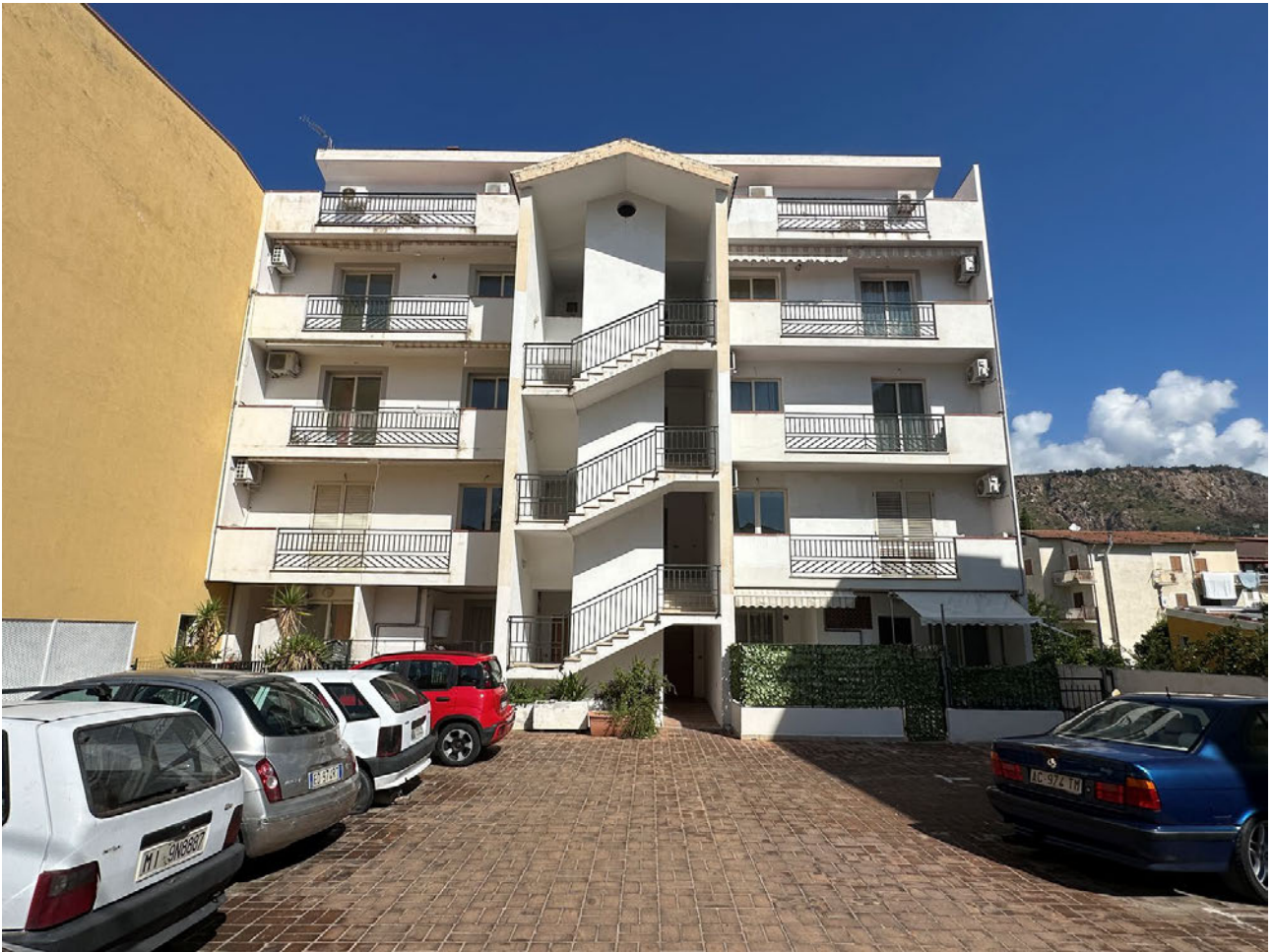
Foto 1: Vista prospetto principale dell'immobile.
