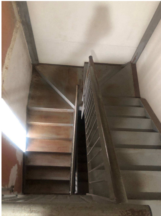
Foto n.24 vista interna scala piano primo
