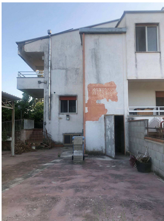
Foto n.11: vista prospetto posteriore
