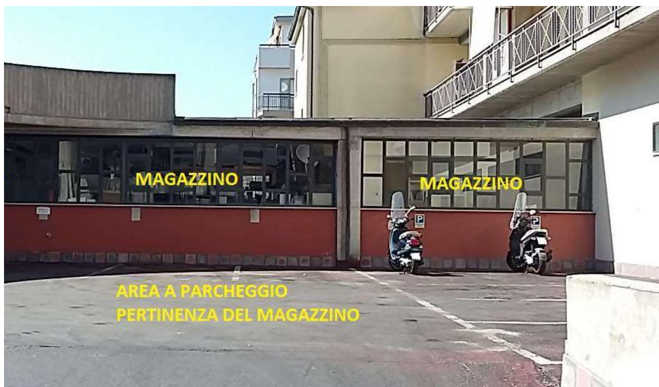
Foto n° 4: Esterno magazzino e piazzale esclusivo lato nord
