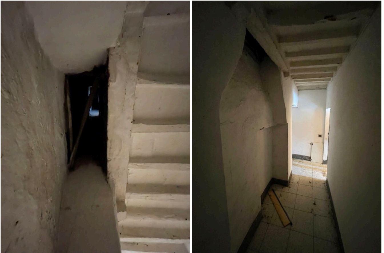
Sub. 10 BCNC vano scala ai sub.ni 6, 7, 8 e 9 - vano scala
