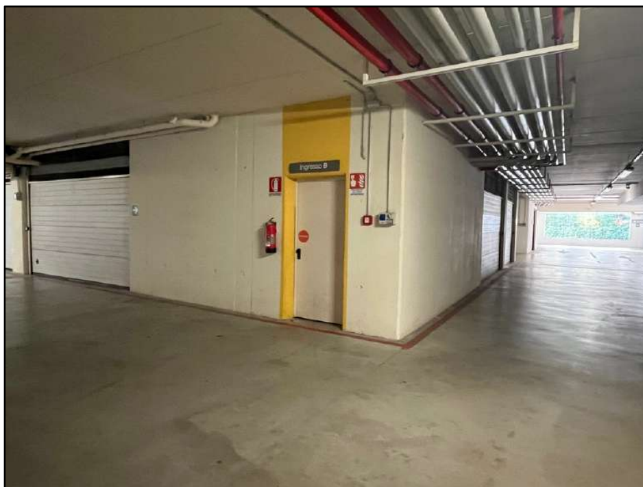
Foto 22A: Il vano scala B – la zona garage del 1° piano interrato
