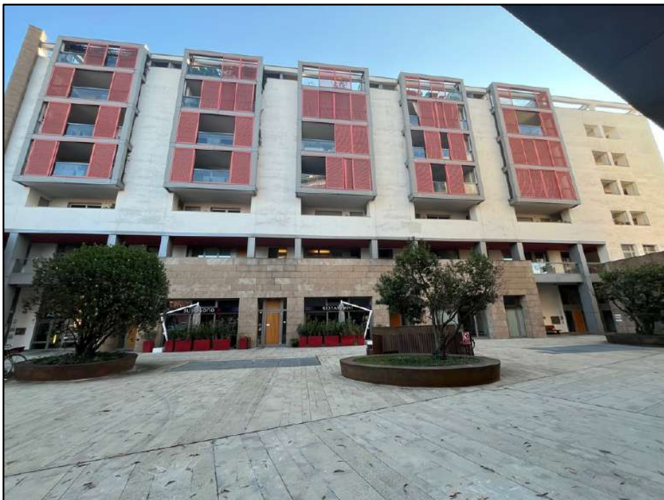
Foto 4A: Facciata ovest della palazzina B
