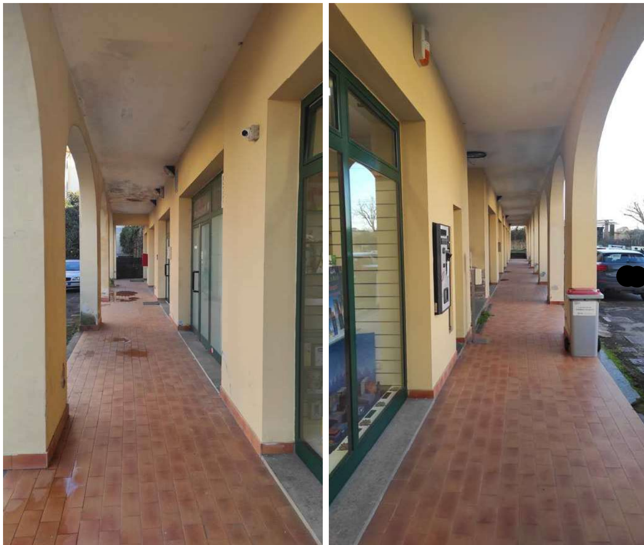
Foto 5, 6 - VISTA DELL'AREA ESTERNA - PORTICO
