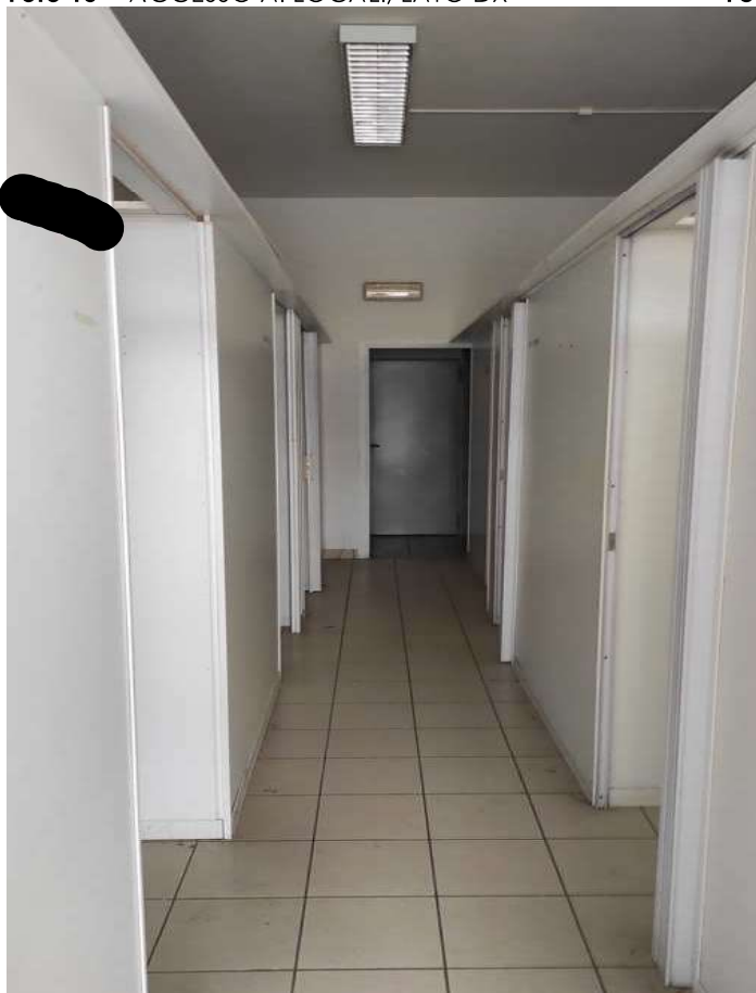
Foto 17 - CORRIDOIO DI DISTRUBUZIONE DA ACCESSO
