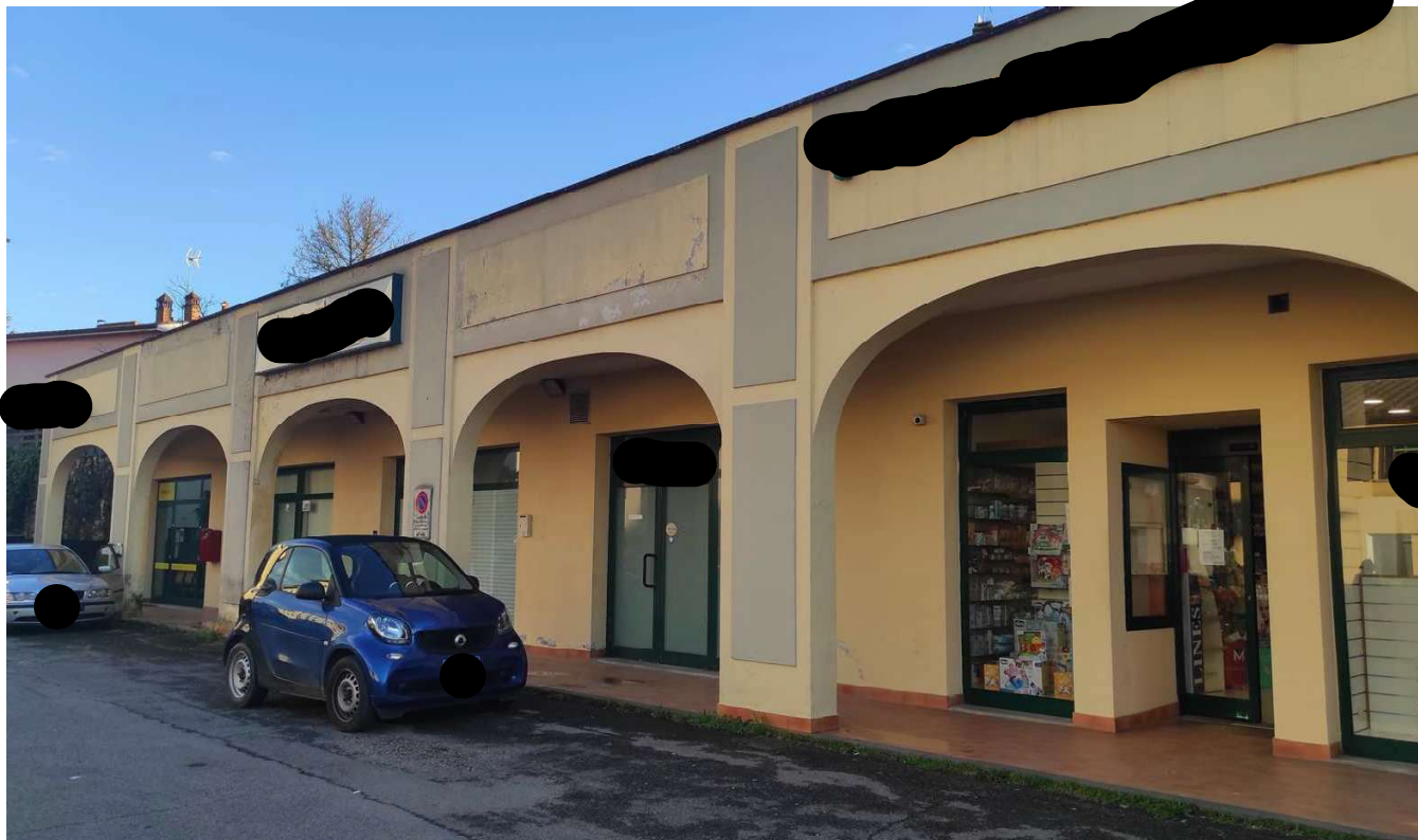
Foto 3 VISTA DELL'AREA ESTERNA SUL FABBRICATO
