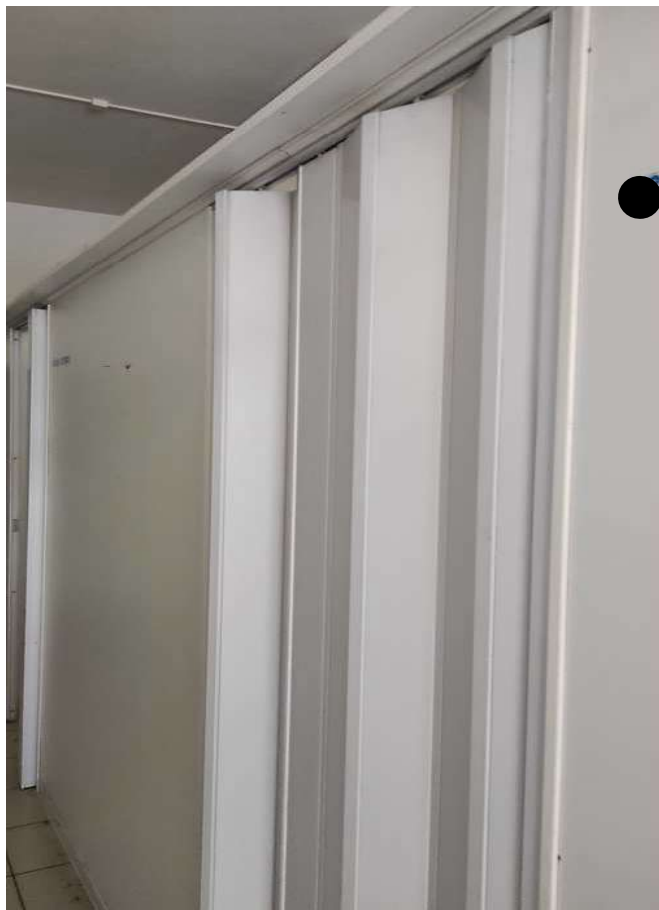
Foto 21 - DETTAGLIO DELLA STRUTTURA A PANNELLI REMOVIBILI CON APERTURE A SOFFIETTO
