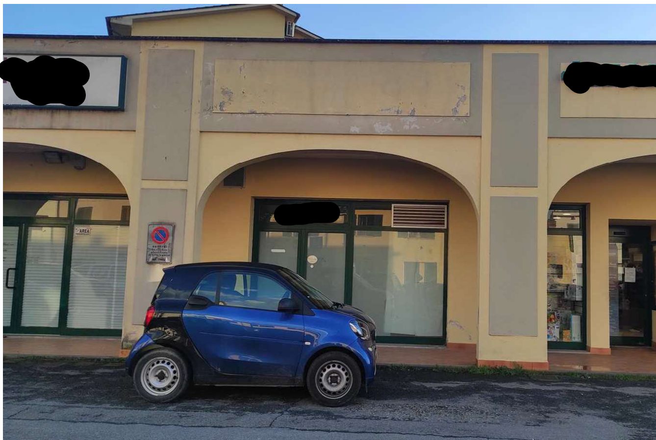
Foto 1 - VISTA DELL'AREA ESTERNA SUL FABBRICATO
