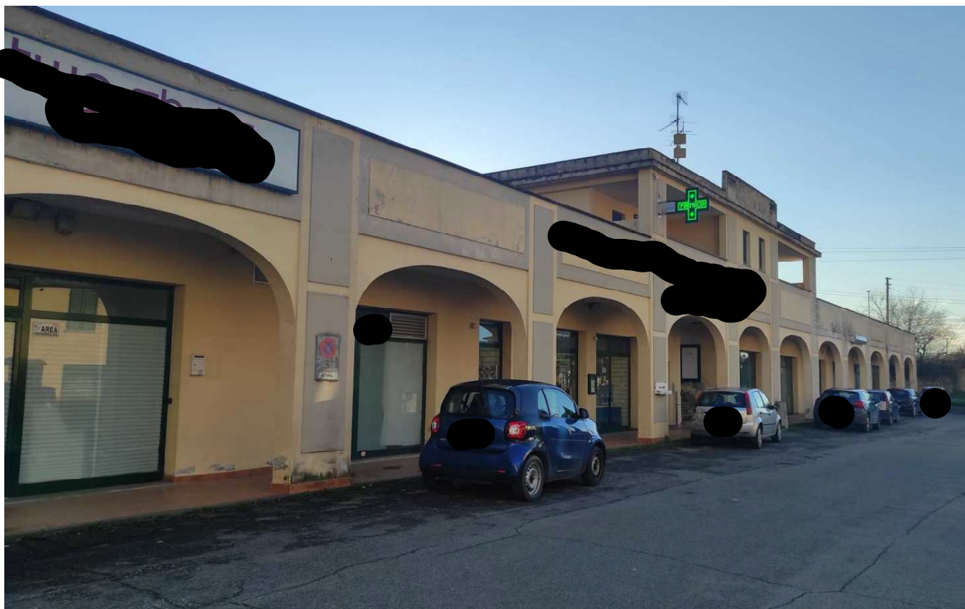
Foto 2 - VISTA DELL'AREA ESTERNA SUL FABBRICATO
