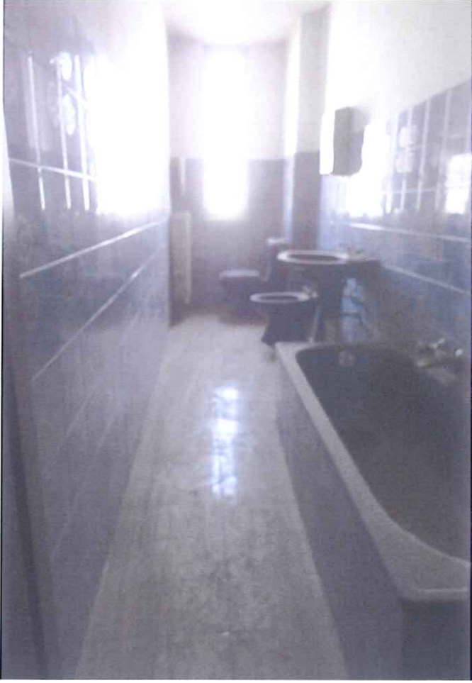
Foto 30 - Blocco 3 - P. Primo - Bagno.JPG
