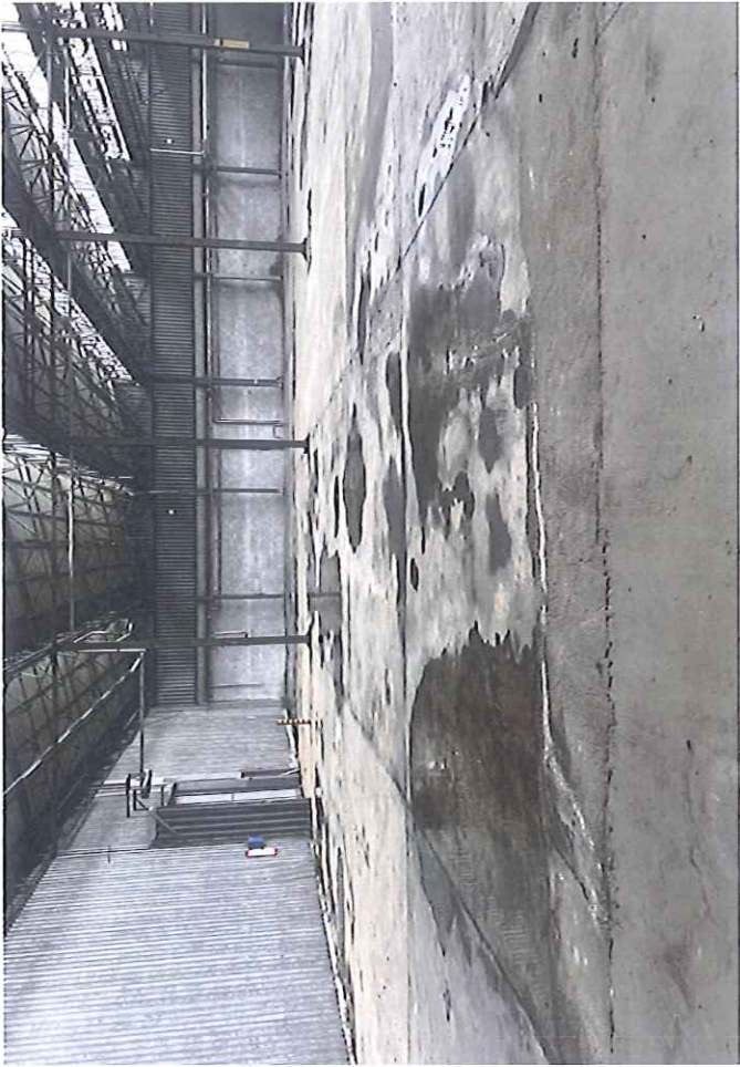
Foto 09 - Blocco 1 - Capannone deposito merci.JPG
