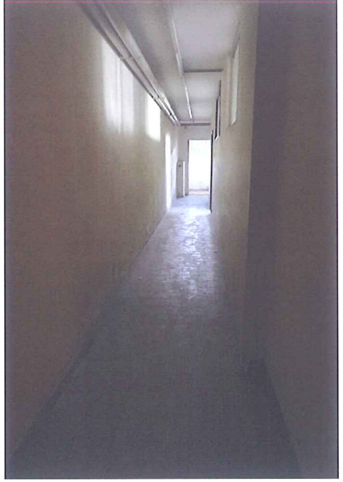
Foto 20 - Blocco 3- P. Terra - Corridoio.JPG
