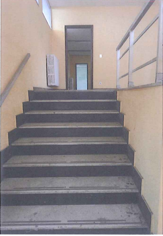
Foto 26 - Blocco 3 - P.Terra - Accesso al P. Primo.JPG
