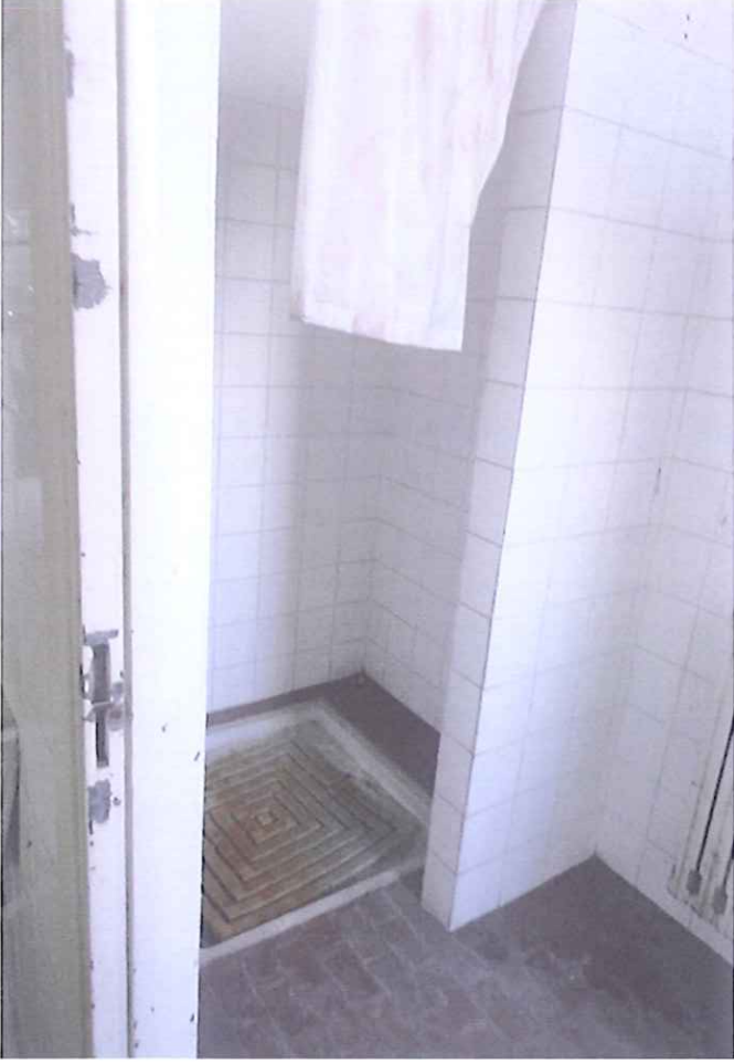
Foto 22 - Blocco 3 - P. Terra - Docce.JPG
