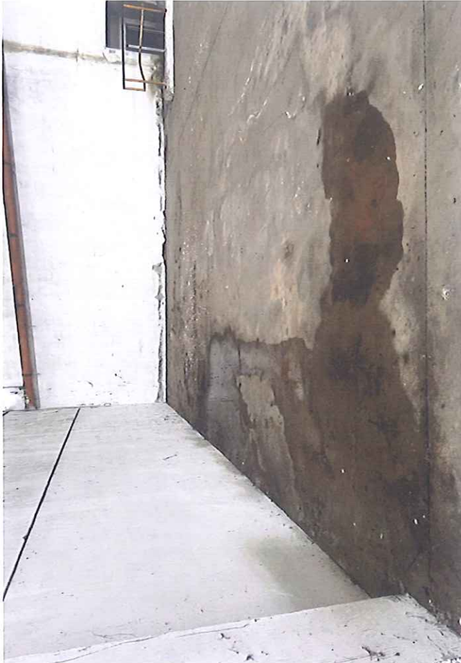
Foto 17 - Blocco 2 - Capannone Deposito merci.JPG
