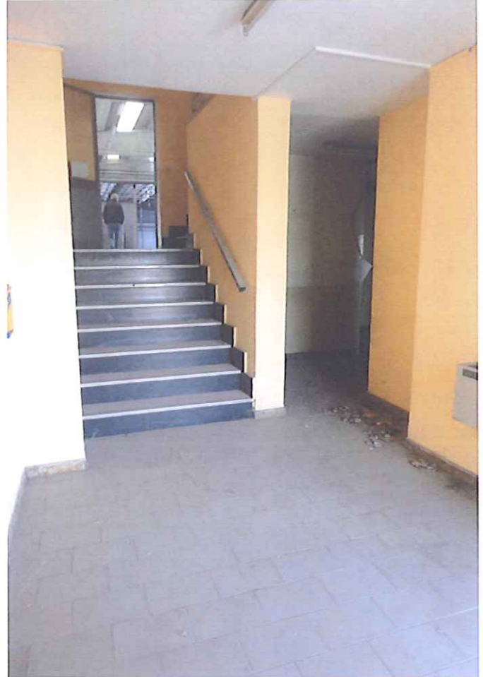
Foto 19 - Blocco 3 - P. Terra - accesso al capannone.JPG
