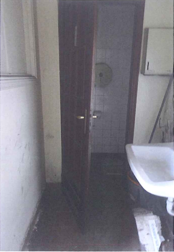
Foto 25 - Blocco 3 - P.Terra - WC.JPG
