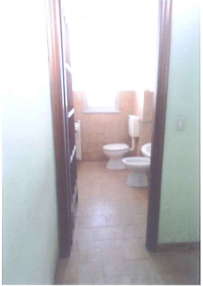
Foto 32 - Blocco 3 - P. Primo - Bagno.JPG
