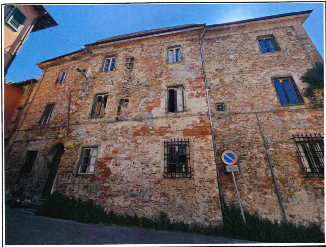
Foto n. 2 Fronte principale del bene oggetto di stima visto dalla Cesare Battisti
